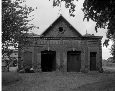
Garage et écurie. Phot. Irwin Leullier IVR22_20018000186X
