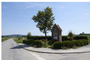
Implantation générale de la chapelle, le Mont Cassel en arrière plan. Phot. Delphine Volto Jourdan IVR32_20245902795NUCA
