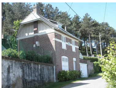
Vue d'ensemble et de trois-quarts. Phot. Elisabeth Justome IVR22_20048001363NUCA
