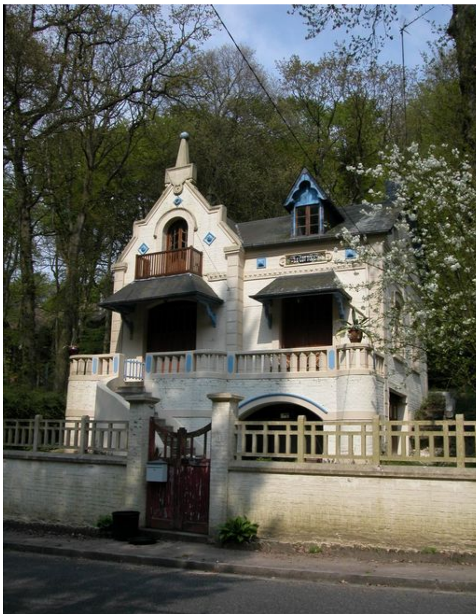
Vue de trois-quarts depuis la rue.
