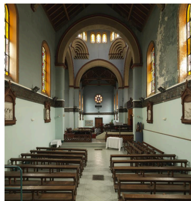
Vue intérieure dans l'axe des ailes des malades. Phot. Thierry Lefébure IVR22_20128000046NUC4A
