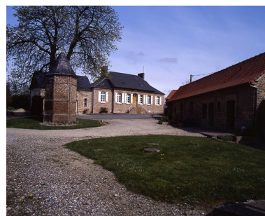
Vue du logis et de l'atelier. Phot. Irwin Leullier IVR22_20078000051XA
