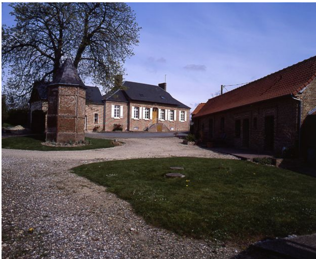
Vue du logis et de l'atelier.
