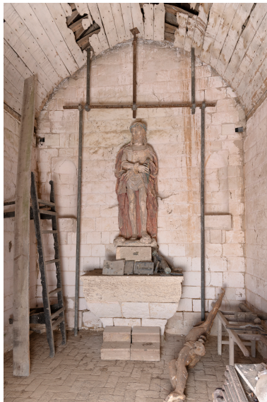
Vue intérieure de la chapelle.
