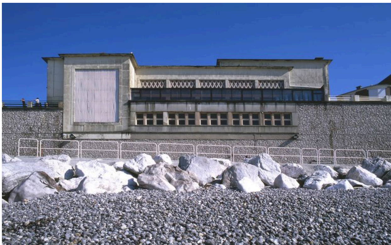
Vue générale, depuis la plage.
