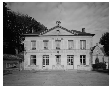
Elévation antérieure. Phot. Jean-Michel Perrin IVR22_19846001310V
