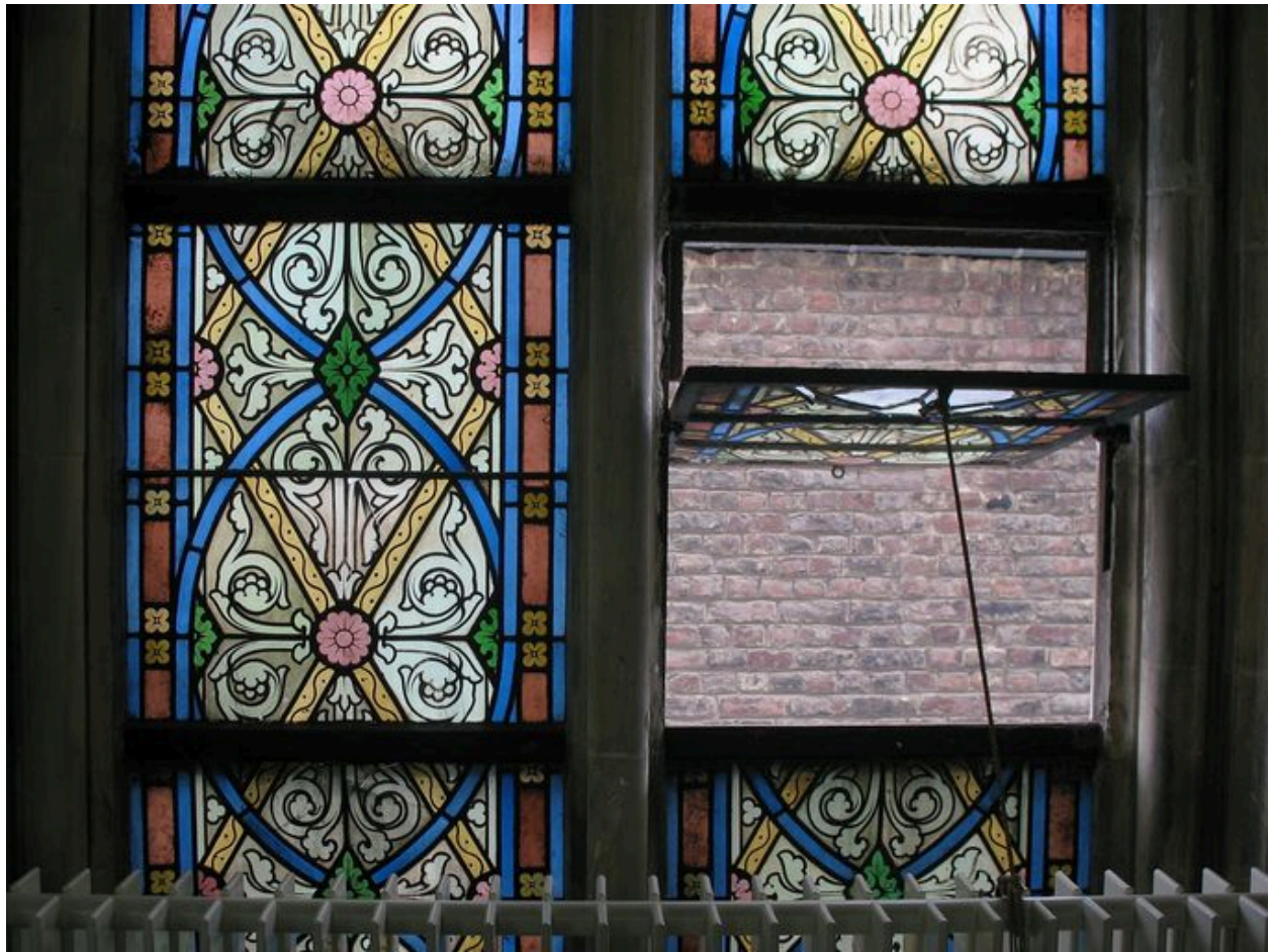
Vue de détail, baie 13
