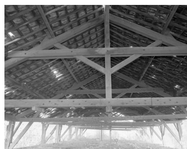
Charpente du bâtiment abritant le four industriel de cuisson. Phot. Franck Bürjes IVR22_19986000280X
