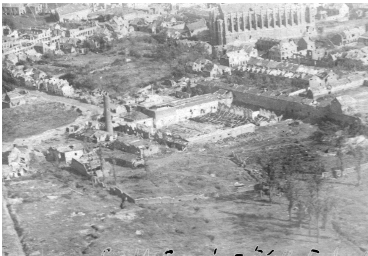
Vue aérienne de la filature, 1918 (AC Saint-Quentin).
