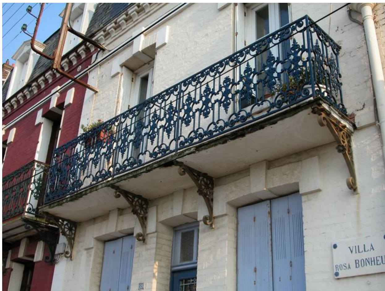
Détail d'un balcon en fonderie.
