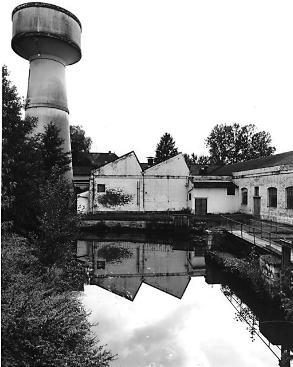
Vue depuis le bassin de retenue, des ateliers de fabrication, avec à gauche le château d'eau, à droite la centrale électrique.
