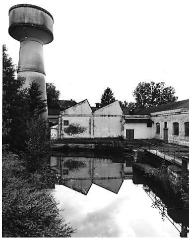
Vue depuis le bassin de retenue, des ateliers de fabrication, avec à gauche le château d'eau, à droite la centrale électrique.
