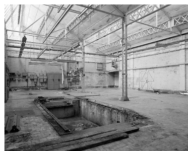
Atelier de fabrication Phot. Thierry Lefébure
