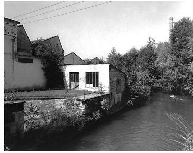
Vue depuis le ponton du déversoir, des ateliers de fabrication.
