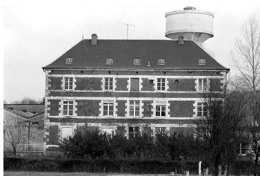
Bâtiment à 4 niveaux de 1825. Phot. Benoît Dufournier IVR22_19910202288Z
