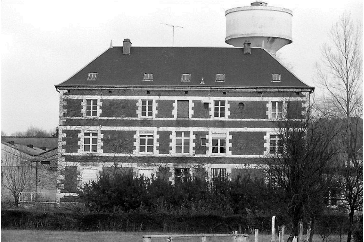
Bâtiment à 4 niveaux de 1825.
