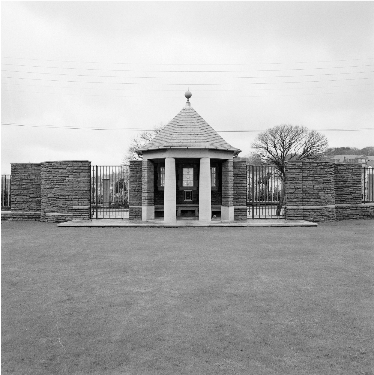
Vue du pavillon d'entrée depuis le cimetière.
