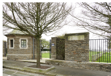
Vue de l'entrée depuis la rue de Dringhen. Phot. Delphine Volto-Jourdan IVR32_20246200072NUCA
