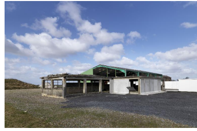
Vestige de l'ancienne sucrerie.
