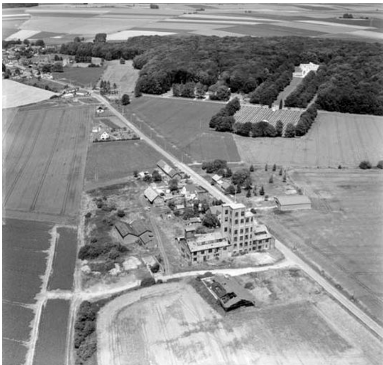
Vue aérienne, flanc sud-ouest.
