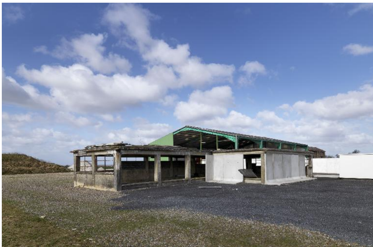
Vestige de l'ancienne sucrerie.
