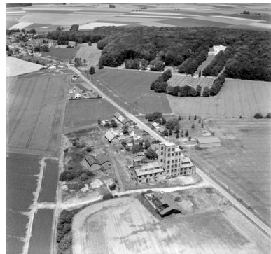
Vue aérienne, flanc sud-ouest. Phot. Phot'R IVR22_19888001261P
