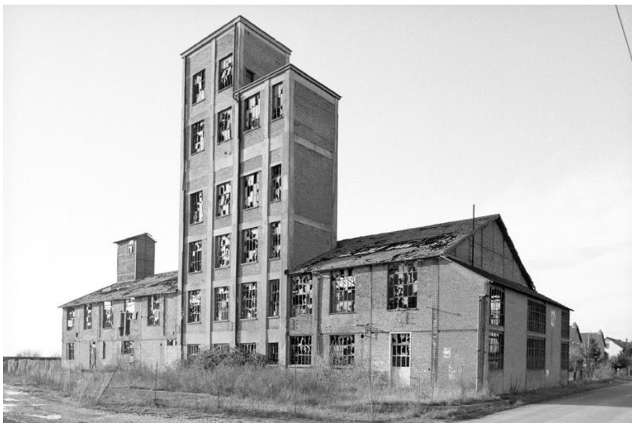
Vue d'ensemble de la râperie depuis le sud.
