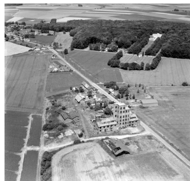
Vue aérienne, flanc sud-ouest. Phot. Phot'R IVR22_19888001261P
