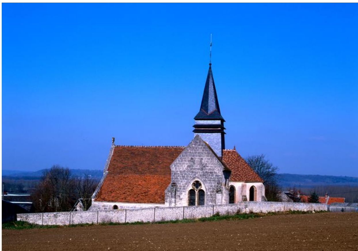
Vue de l'élévation sud.
