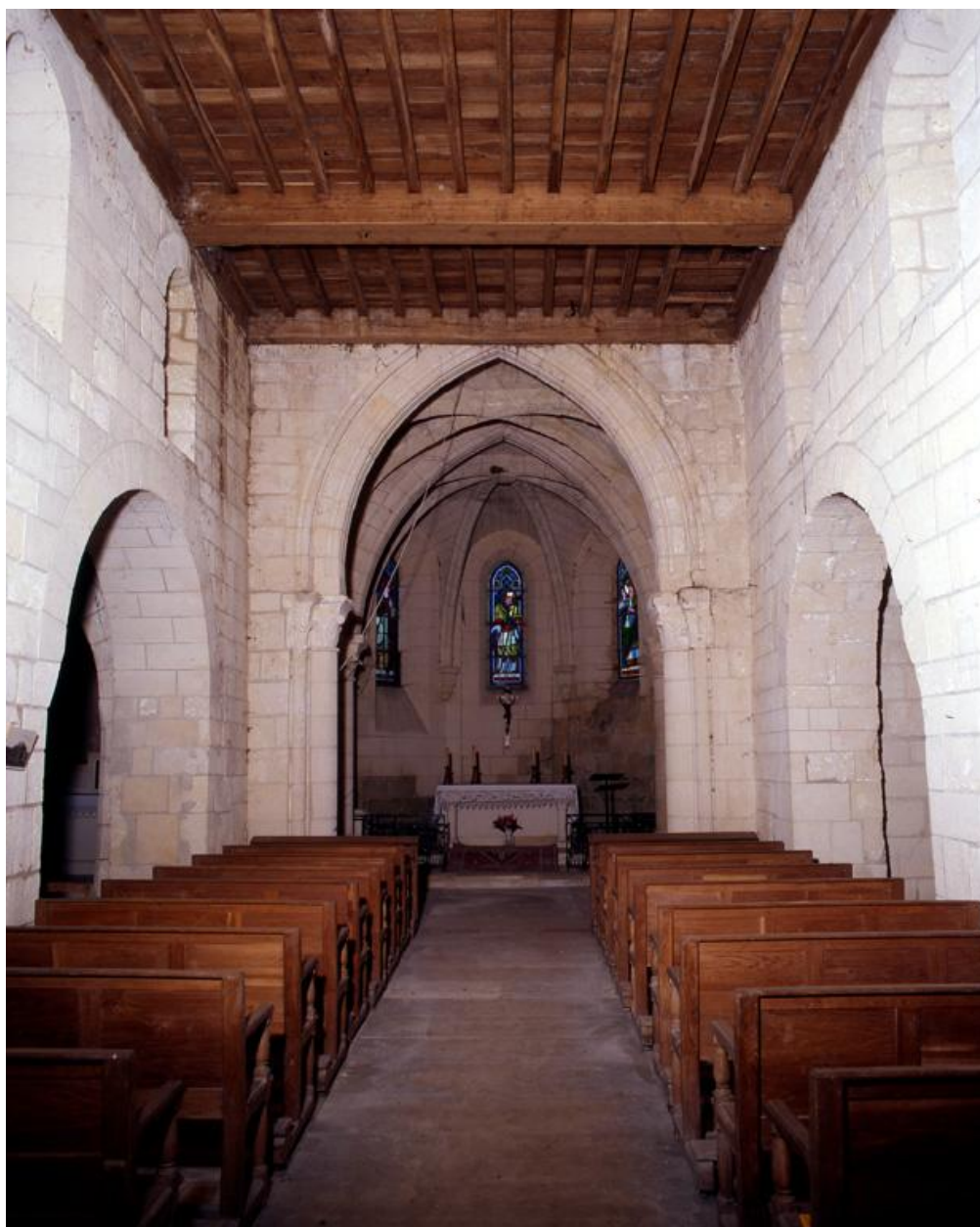
Vue intérieure, depuis l'entrée vers le chœur.
