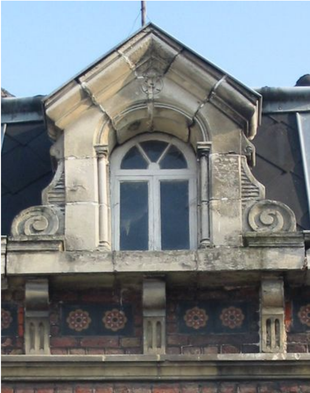
Pan coupé, étage de comble : lucarne, corbeaux de pierre et céramique.
