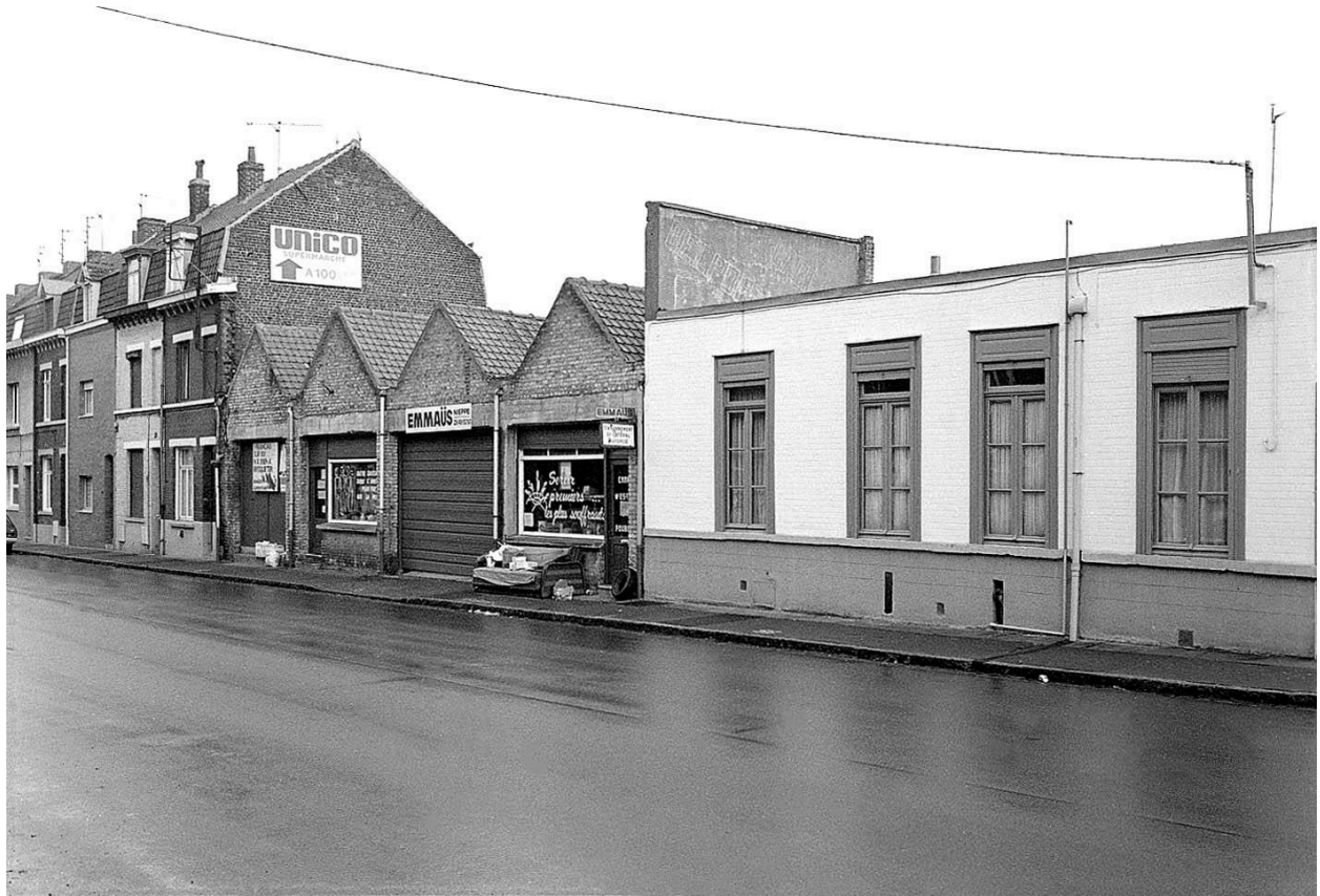
Atelier de fabrication, rue des Quais.
