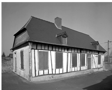
Vue générale. Phot. Franck Bürjes IVR22_19990201198V
