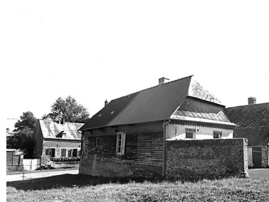
Elévation postérieure. Phot. Xavier-Philippe Guiochon IVR22_19980202370Z
