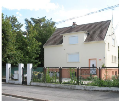
Maison d'ingénieur construite en 1958 rue Charles Somasco. Phot. Clarisse Lorieux IVR22_20096005122NUCA
