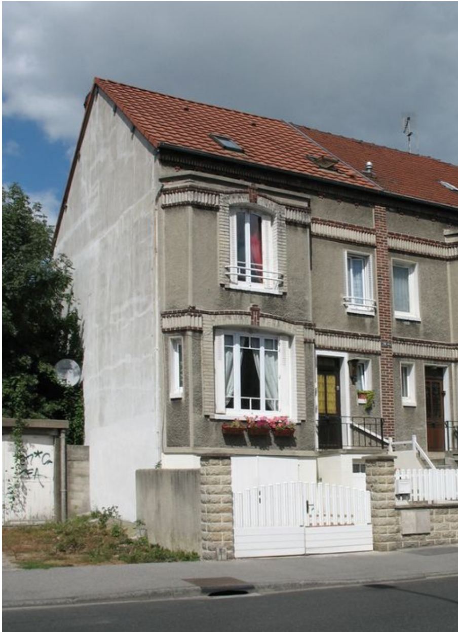
Vue générale de la maison acquise en 1948 par la société Vieille-Montagne, rue Claude-Péroche.
