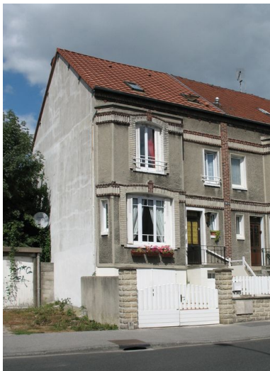
Vue générale de la maison acquise en 1948 par la société Vieille-Montagne, rue Claude-Péroche. Phot. Clarisse Lorieux IVR22_20096005125NUCA
