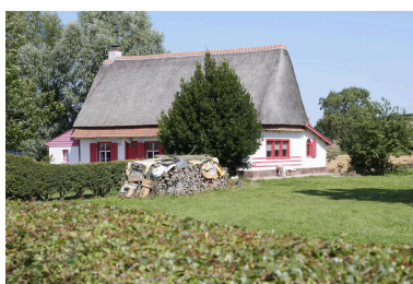
Façade sud et pignon est.
