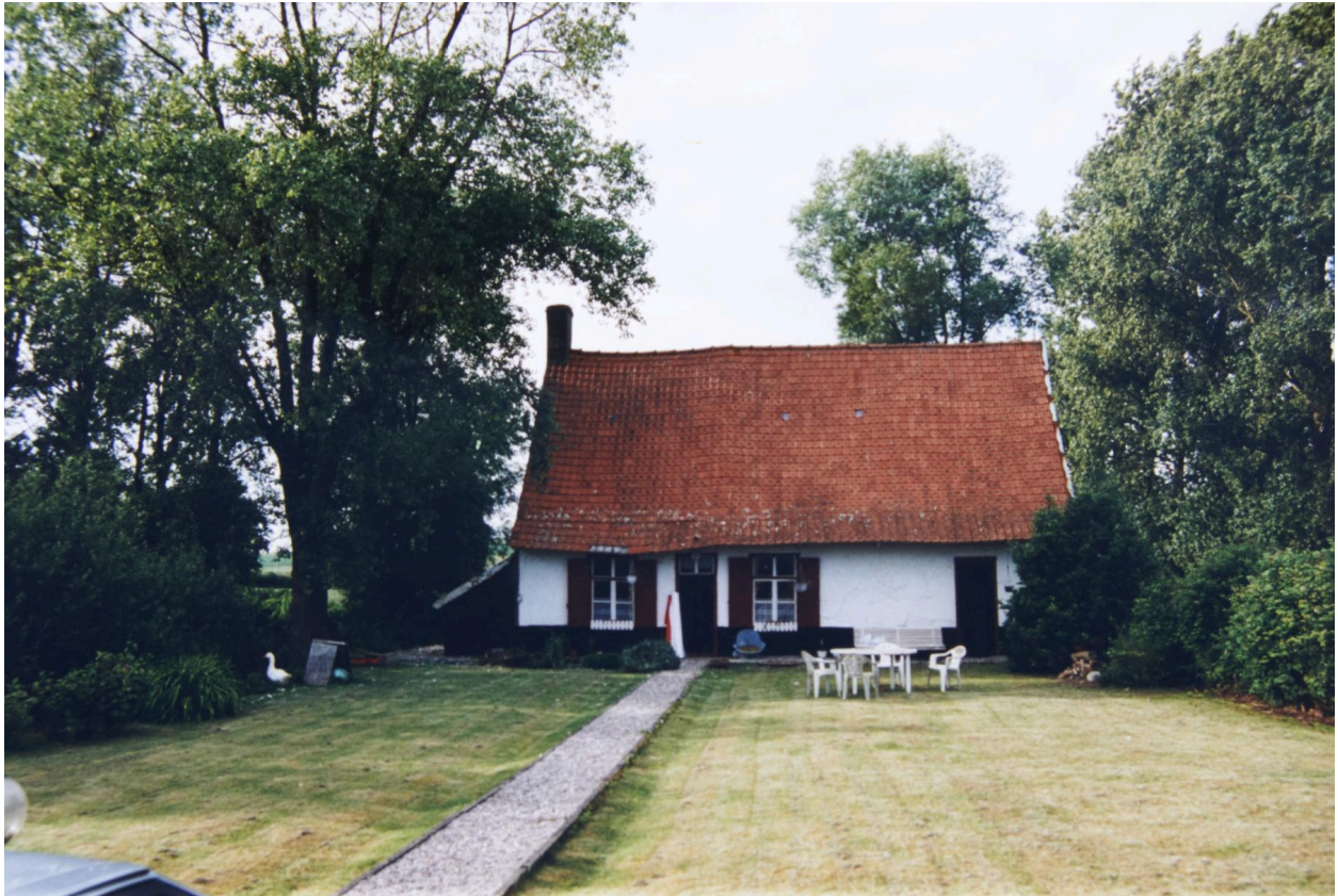
La chaumière dans les années 1990. Toit en pannes flamandes (coll. Comité Flamand de France).
