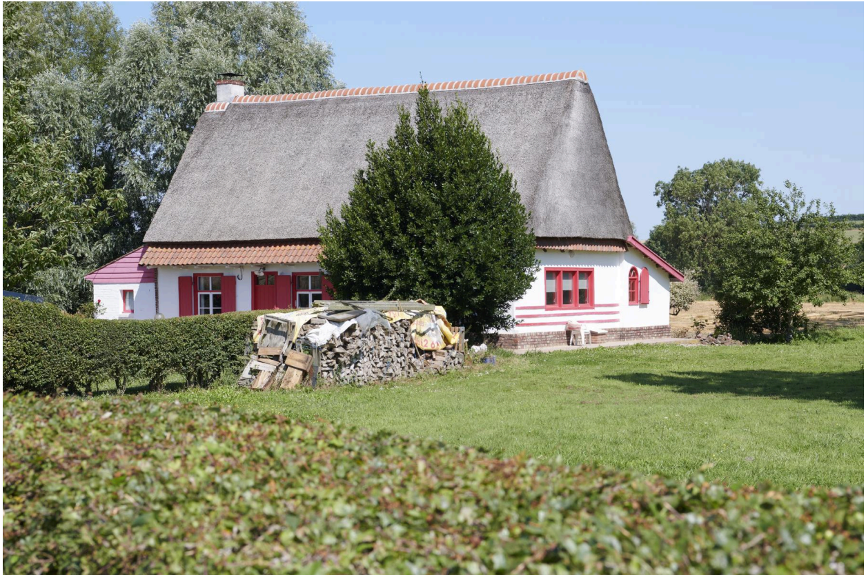
Façade sud et pignon est.
