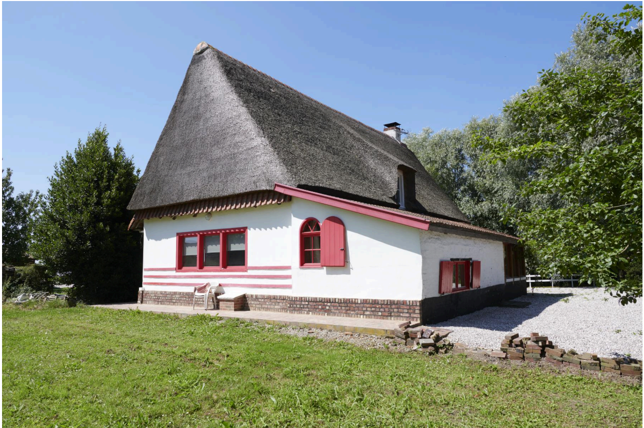
Pignon est et façade nord.
