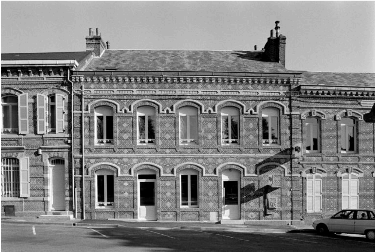
Vue de la façade principale sur la place.
