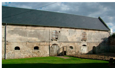
Vue de l'étable Phot. Frédéric Fournis IVR22_20040202815NUCA
