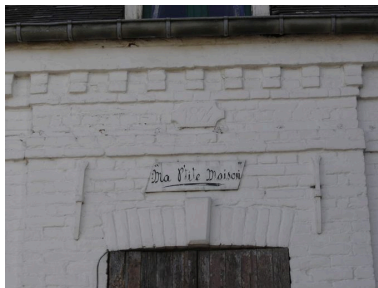
Détail de la date portée. Phot. Inès Guérin IVR22_20058005285NUCA
