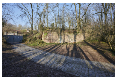
Batterie de flanquement du ravelin. Phot. Pierre Thibaut IVR32_20235900160NUCA
