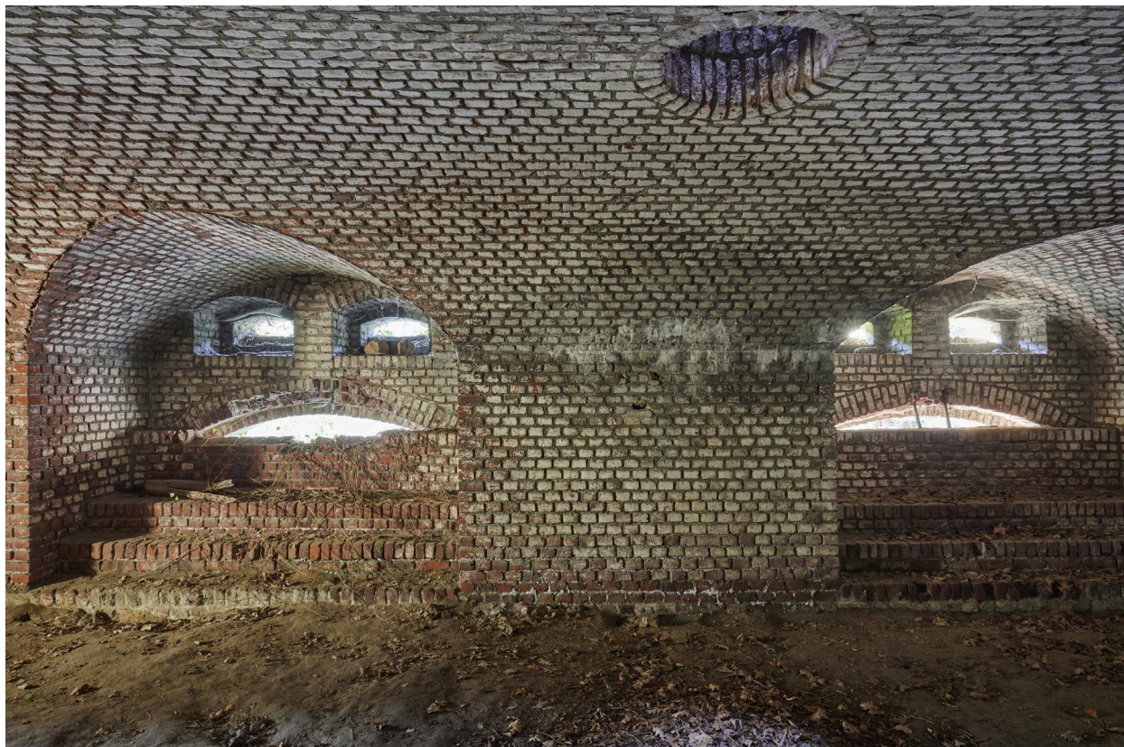
Aile ouest. Caponnière simple. Meutrières à grenades. Au premier plan, la cheminée d'évacuation des fumées.
