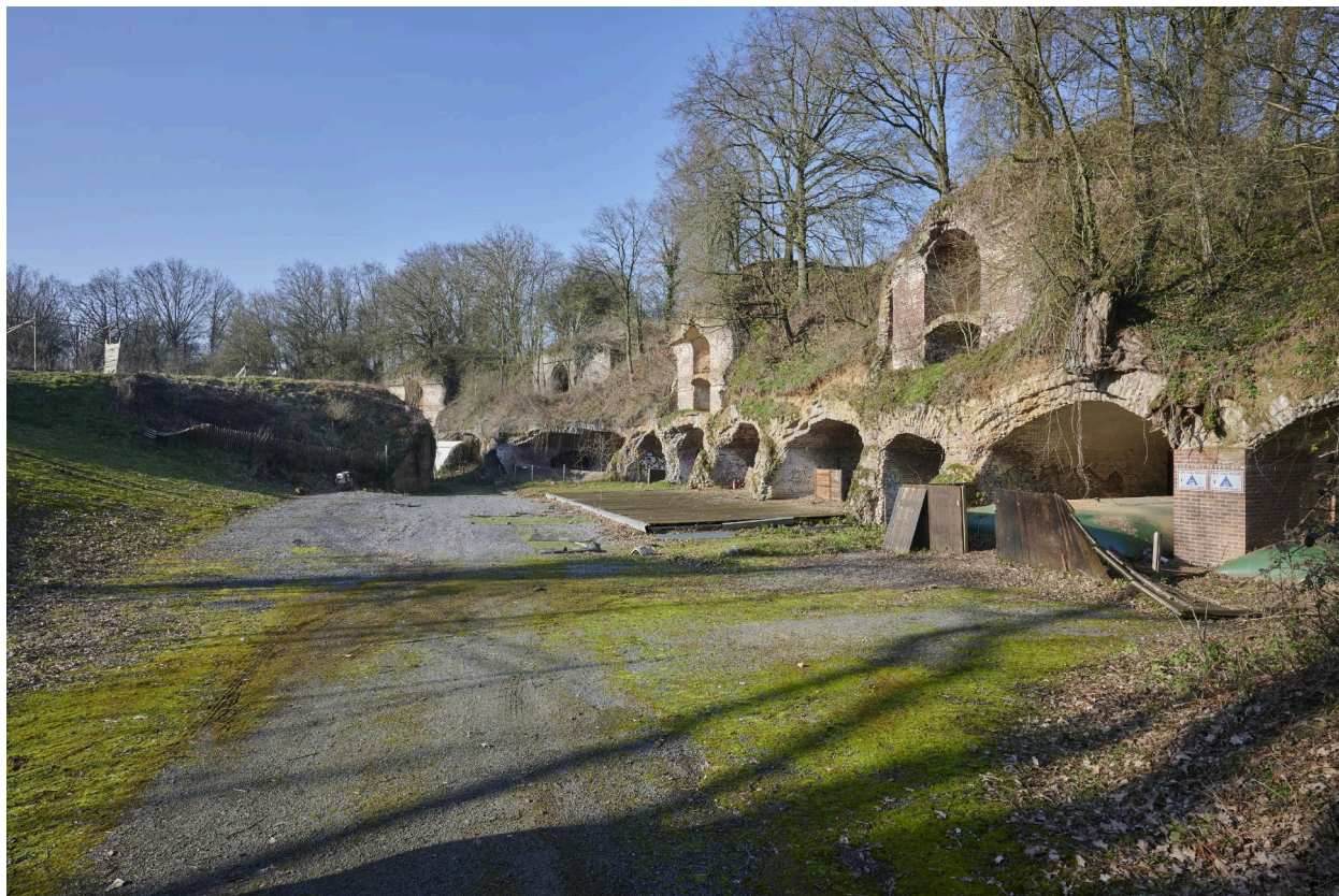
Aile est. Crête d'artillerie, vers l'ouest.
