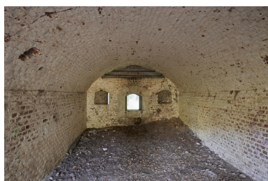
Aile est. Chambre de tir de la caponnière double et cheminée d'évacuation des fumées. Phot. Pierre Thibaut IVR32_20235900130NUCA
