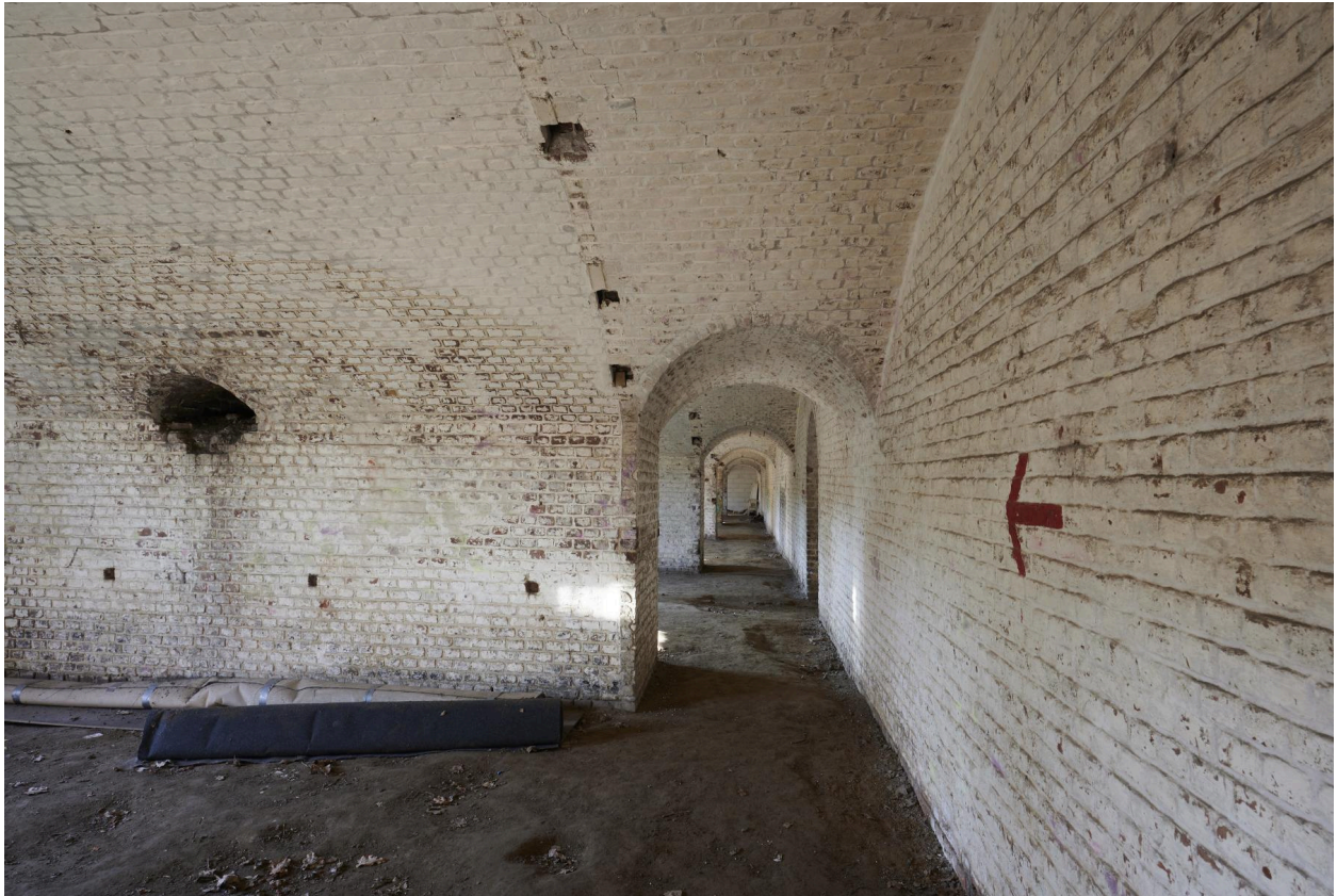
Aile est. Couloir sous la crête d'artillerie.
