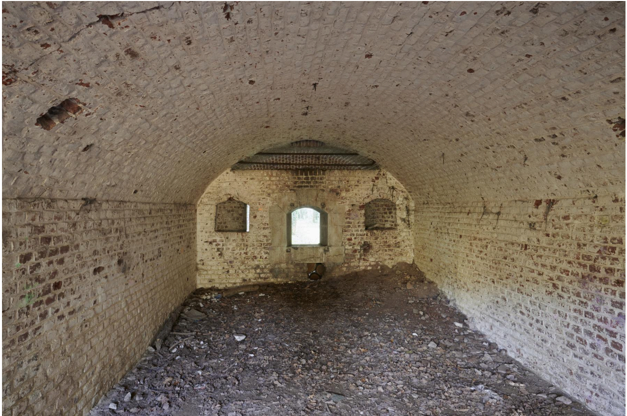
Aile est. Chambre de tir de la caponnière double et cheminée d'évacuation des fumées.
