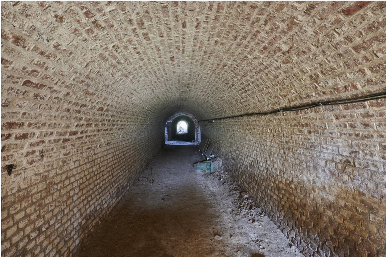
Aile est. Couloir de la caponnière double.
