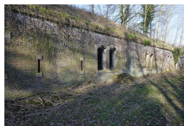
Aile ouest. Casernes de gorge et créneaux de fusillade dans le mur d'escarpe. Phot. Pierre Thibaut IVR32_20235900155NUCA
