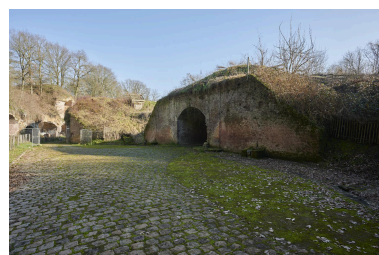
Aile ouest. Vestiges de la crête d'artillerie. Phot. Pierre Thibaut IVR32_20235900142NUCA
