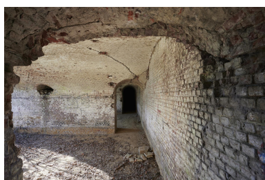
Couloir reliant les chambres des sous-officiers (aile ouest). Phot. Pierre Thibaut IVR32_20235900115NUCA
