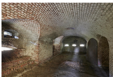
Aile ouest. Caponnière simple. Embrasures de tir et meutrière à grenades (à gauche). Phot. Pierre Thibaut IVR32_20235900150NUCA
