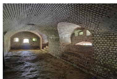
Aile ouest. Caponnière simple. Chambre de tir et meutrière à grenades (à droite). Phot. Pierre Thibaut IVR32_20235900149NUCA
