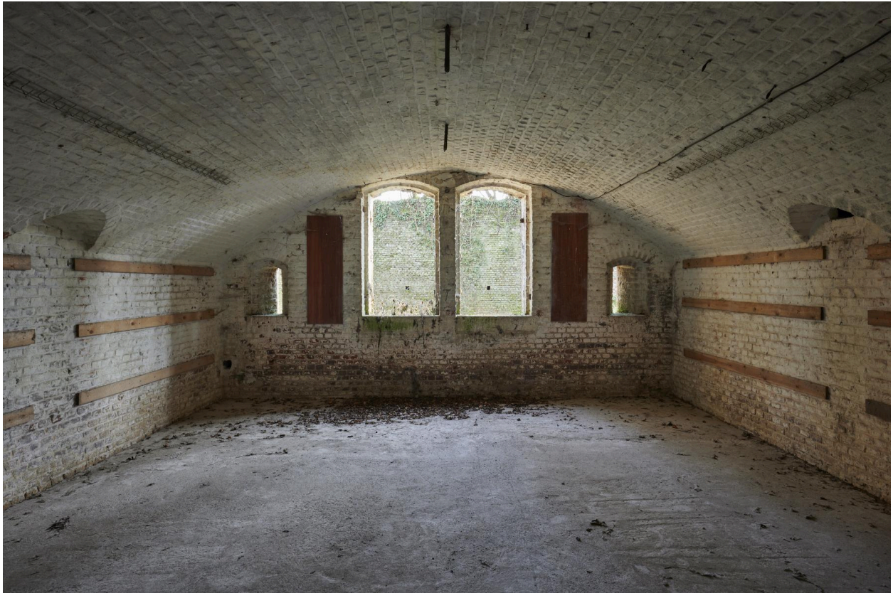
Vue intérieure d'une caserne de flanquement.
