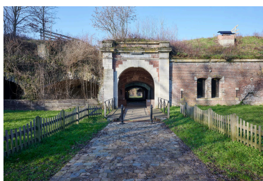
Front du gorge. Entrée du fort. Phot. Pierre Thibaut IVR32_20235900163NUCA
