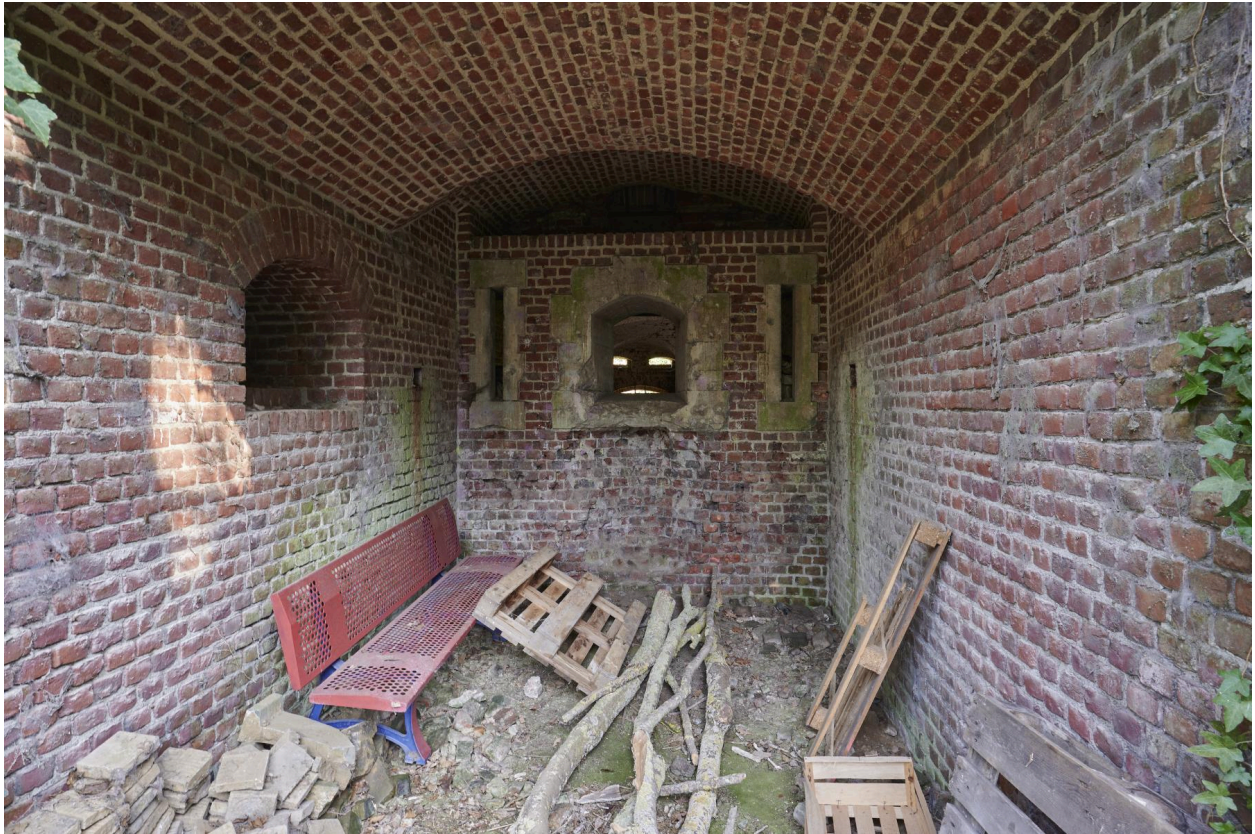
Aile ouest. Vue depuis le fossé d'une des chambres de tir de la caponnière simple.
