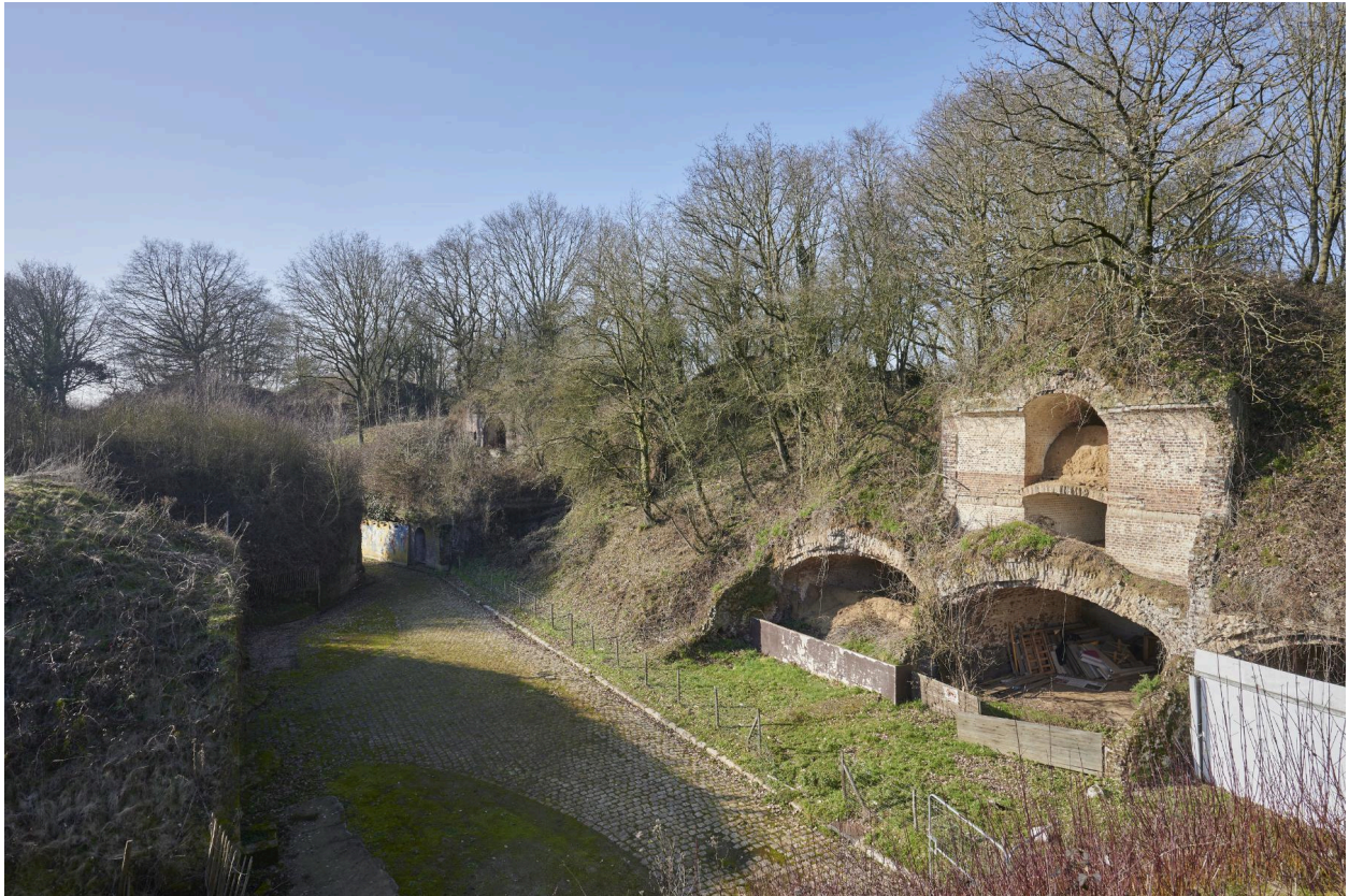
Aile est. Crête d'artillerie, vers le nord-ouest.
