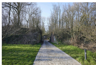
Entrée du ravelin, vers le nord. Phot. Pierre Thibaut IVR32_20235900161NUCA
