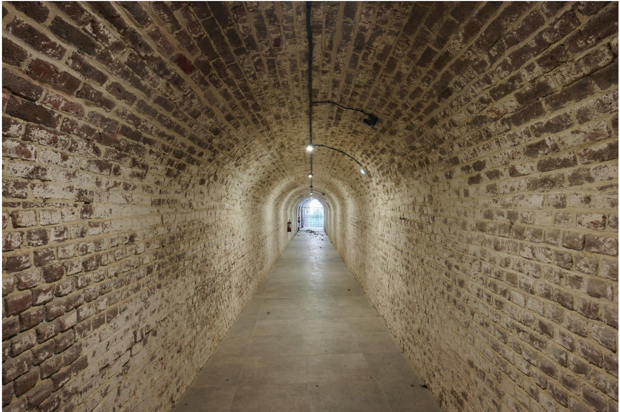
Aile est. Couloir menant à la crête d'artillerie.
