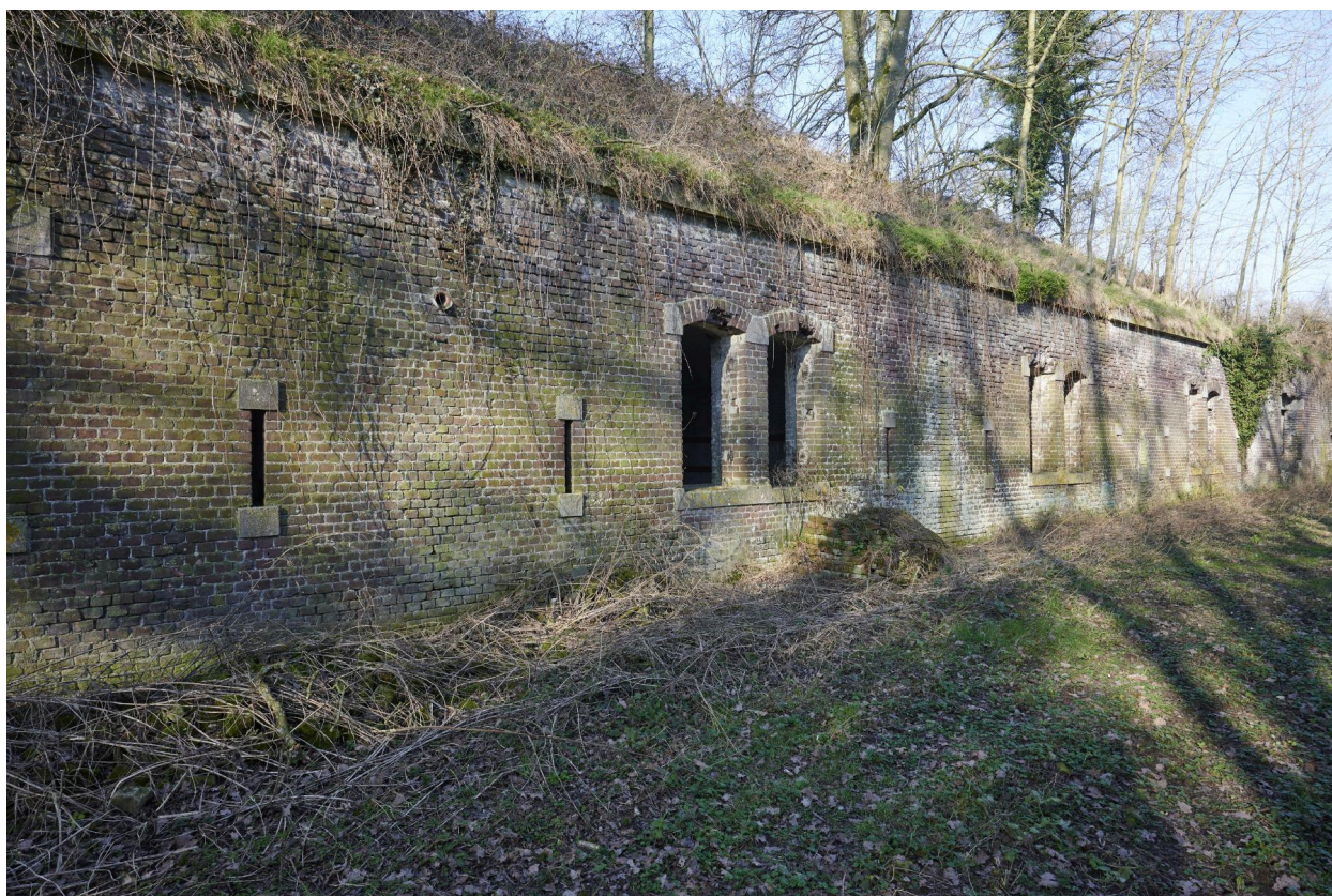
Aile ouest. Casernes de gorge et créneaux de fusillade dans le mur d'escarpe.
