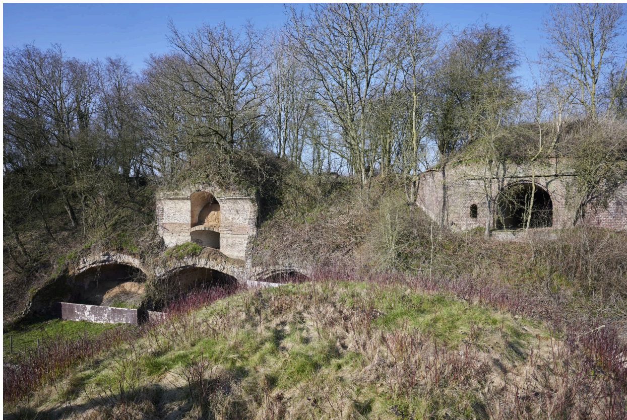
Aile est. Crête d'artillerie, vers le nord.
