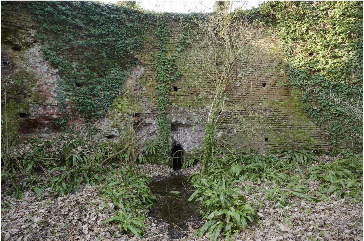
Orifice maçonné permettant l'écoulement des eaux au travers du mur de contrescarpe.
