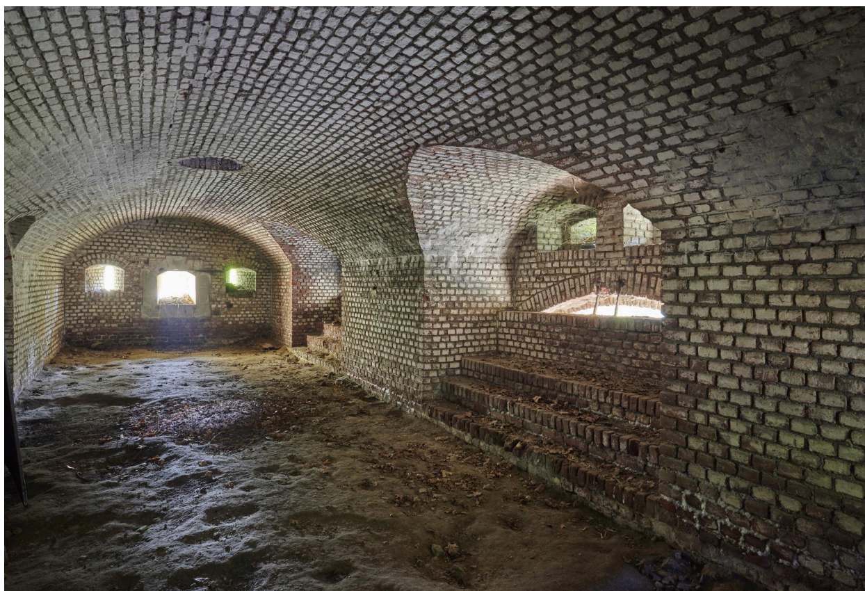
Aile ouest. Caponnière simple. Chambre de tir et meutrière à grenades (à droite).
