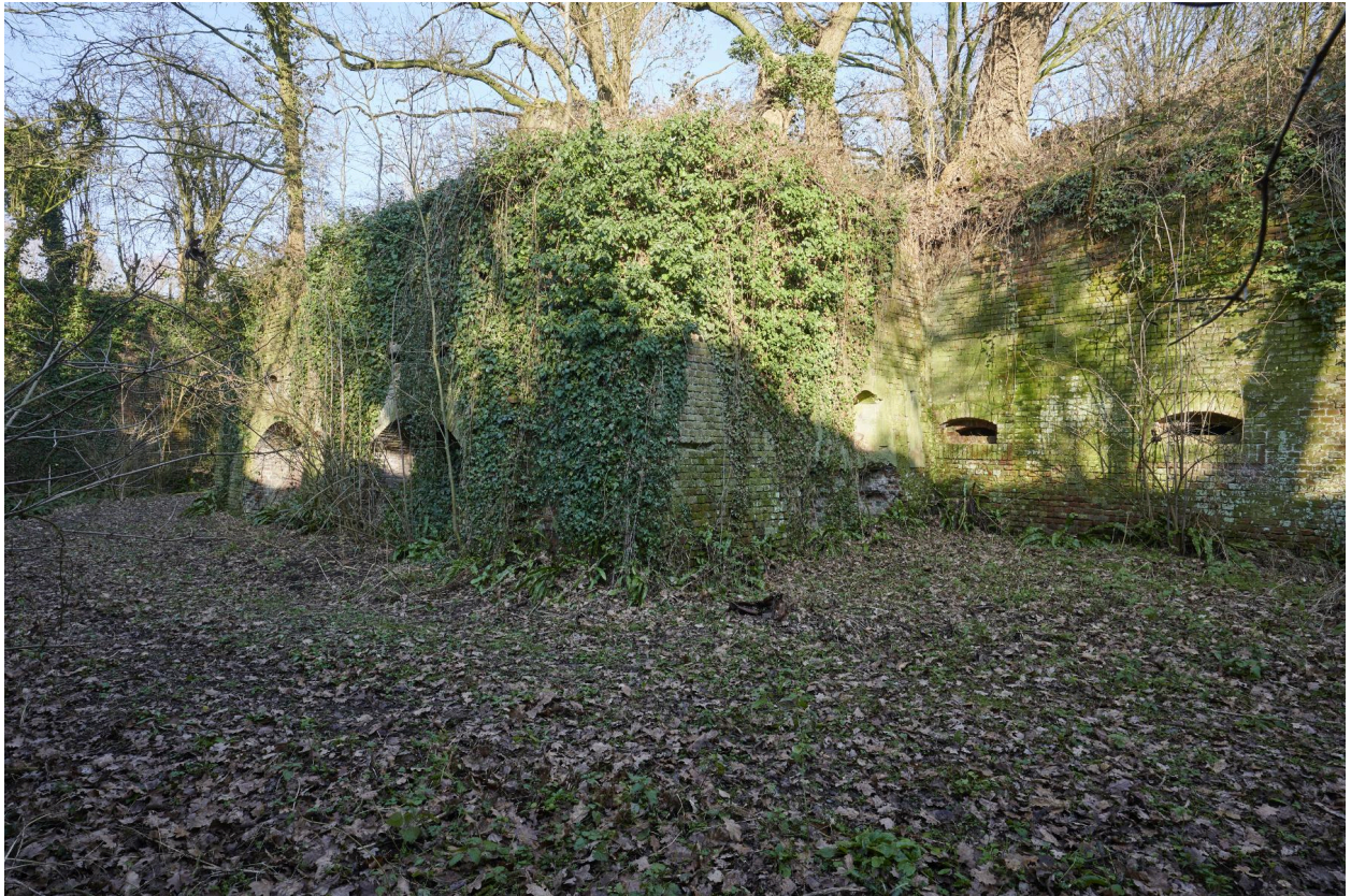
Aile ouest. Caponnière simple. Embrasures de tir des casemates de flanquement.
