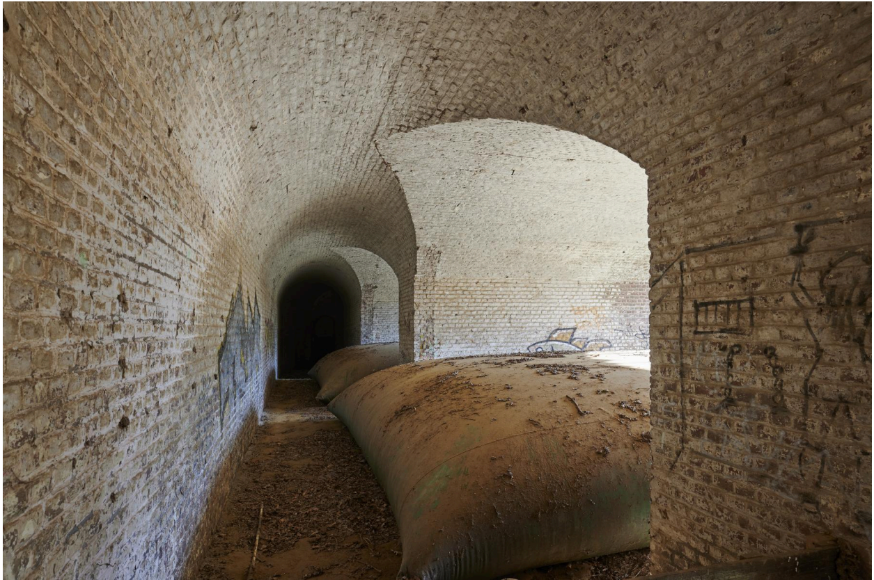
Aile est. Bâches à incendie sous la crête de tir.
