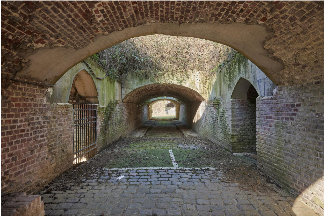
Passage couvert menant à la cour centrale.
