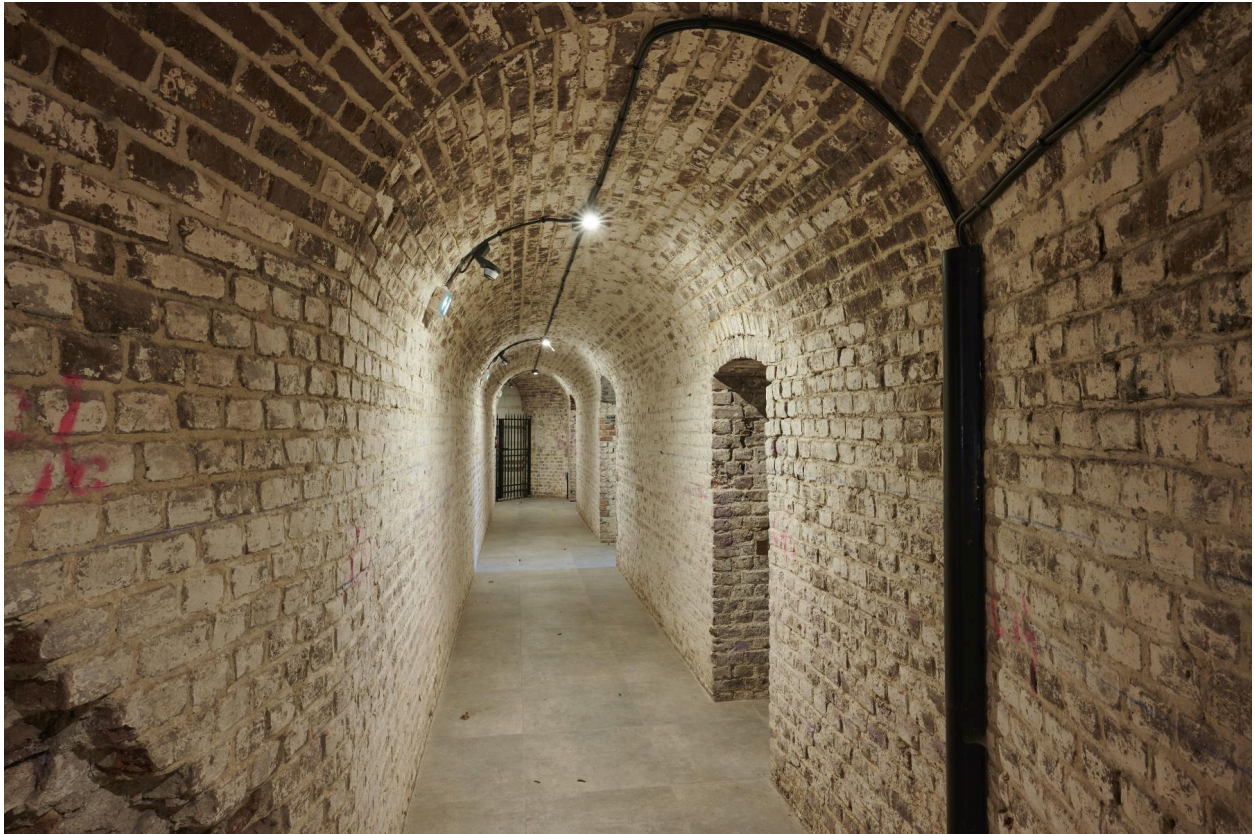
Couloir reliant les casernes de l'aile est.
