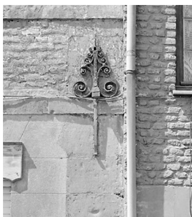
Maison n° 59, détail : fer d'ancrage. Phot. Pierre Thibaut IVR31_20015901344X
