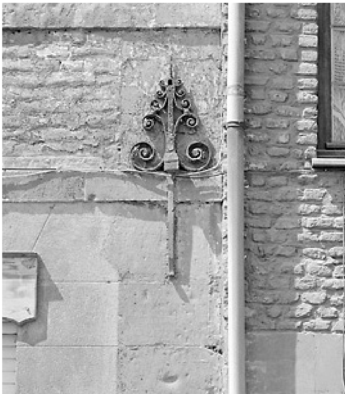
Maison n° 59, détail : fer d'ancrage.
