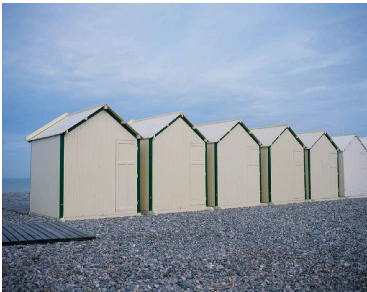
Ensemble de cabines, élévations postérieures.
