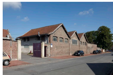
Depuis la rue Molière, l'arrière des tueries et de l'atelier de dépeçage. Phot. Hubert Bouvet IVR31_20105900361NUC4A
