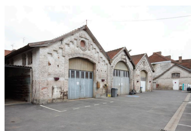
Cour, vue générale des tueries et de l'atelier de dépeçage. Au fond, l'étable à cochons. Phot. Hubert Bouvet IVR31_20105900386NUC4A
