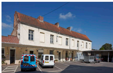
Cour, vue du corps de bâtiment aménagé pour accueillir le logement du concierge, l'étable des bœufs et celle des taureaux. Phot. Hubert Bouvet IVR31_20105900360NUC4A
