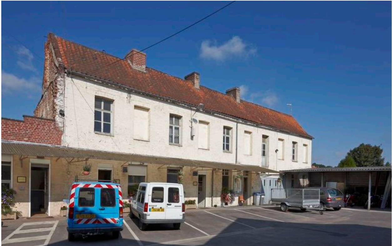
Cour, vue du corps de bâtiment aménagé pour accueillir le logement du concierge, l'étable des bœufs et celle des taureaux.
