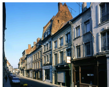
La rue Camille-Desmoulins, depuis l'ouest. Phot. Marie-Laure Monnehay-Vulliet IVR22_19990205960VA
