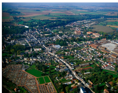
Vue aérienne. Phot. Phot'R IVR22_19990206423XA
