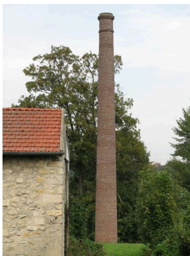
Cheminée de la machine à vapeur. Phot. Clarisse Lorieux IVR22_20066005000NUCA
