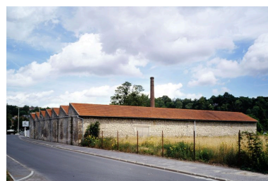
Ateliers couverts de sheds en dents de scie de l'usine de lacets. Phot. Thierry Lefébure IVR22_20076000029XA
