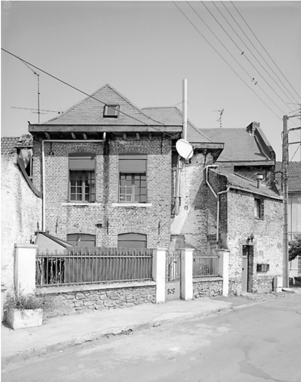
Vue générale des façades arrière (état en 2001).
