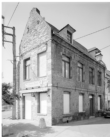
Vue générale du mur-pignon portant la date de 1507 et de la façade rue du Marais (état en 2001).
