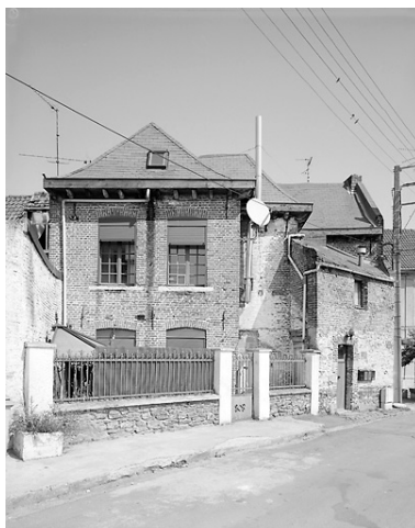
Vue générale des façades arrière (état en 2001).
