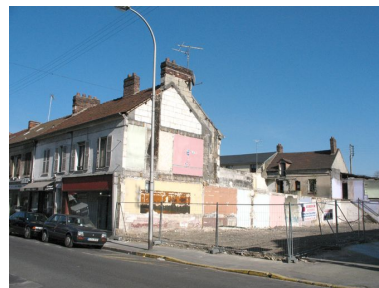
A la faveur de la démolition d'un p  t   de maisons en avril 2007, la maison de Prosper D  sir   Dessens, entrepreneur de ma  onnerie r  v  le une inscription sur la souche de la chemin  e. Phot. Clarisse Lorieux IVR22_20076005469NUCA
