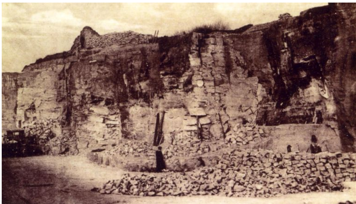
Anciennes carrières Daubin à Saint-Maximin (collection particulière).
