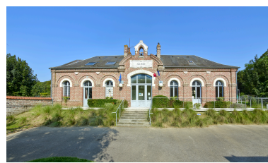
Vue de la façade sud. Phot. Thierry Lefébure IVR32_20248001192NUCA
