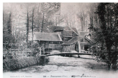
Vue d'ensemble des bâtiments de production de la scierie avec la rivière du Thérain au premier plan. Phot. Fournier Bertrand (reproduction) IVR22_20046003049NUCAB
