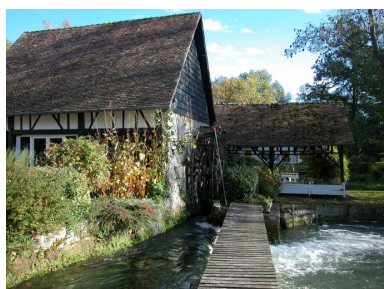
Le coursier et le déversoir du moulin. Phot. Bertrand Fournier IVR22_20046003052NUCA
