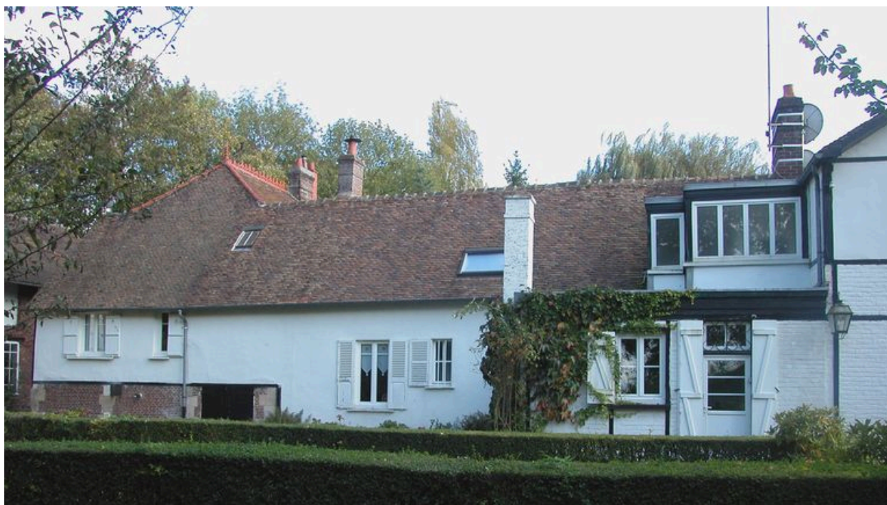
Façade postérieure du logement patronal.
