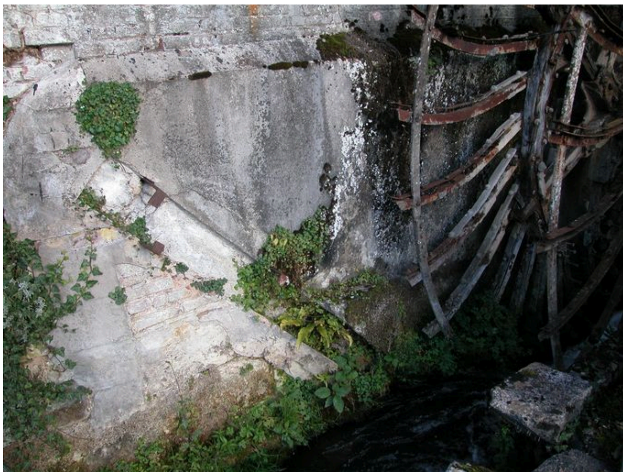
Détail de la trace de la vanne ouvrière plongeante.
