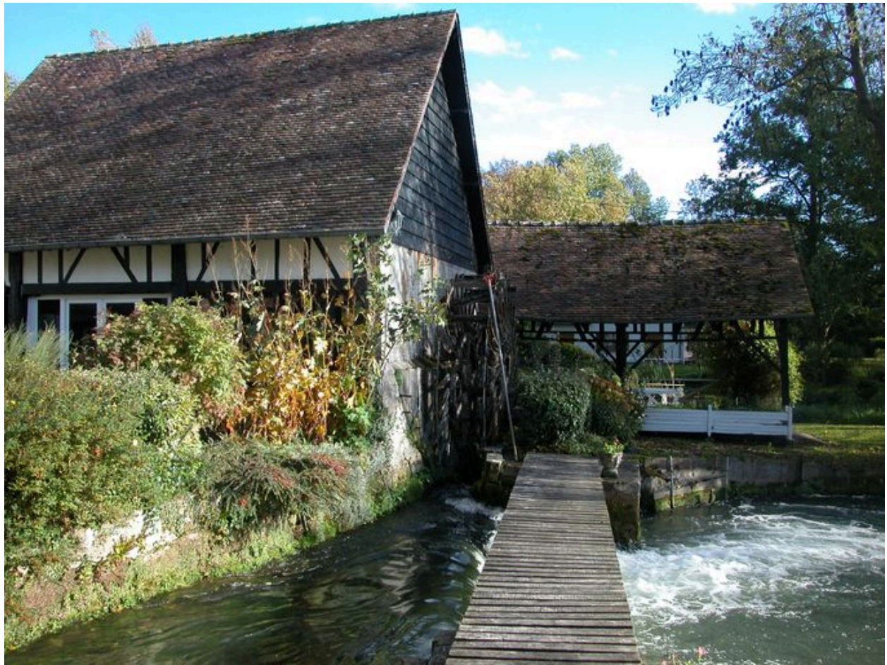
Le coursier et le déversoir du moulin.
