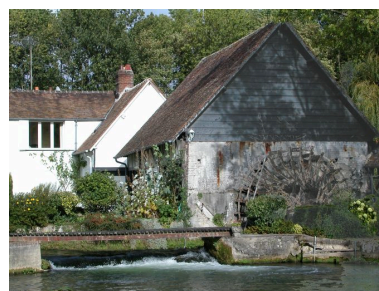
Vue du pignon du moulin hydraulique. Phot. Bertrand Fournier IVR22_20046003000NUCA
