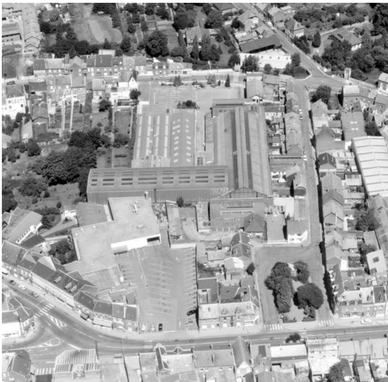
Vue aérienne, flanc sud.
