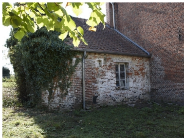
Vue de l'atelier (?). Phot. Pierre Thibaut IVR31_20095903207NUCA
