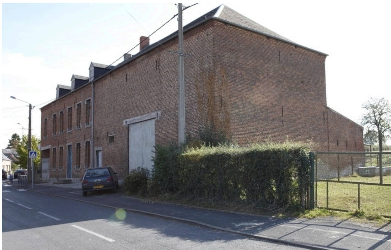
Vue générale depuis le nord.
