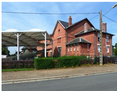
Vue depuis la rue Guillard-Marcel. Phot. Isabelle Barbedor IVR32_20170205506NUCA
