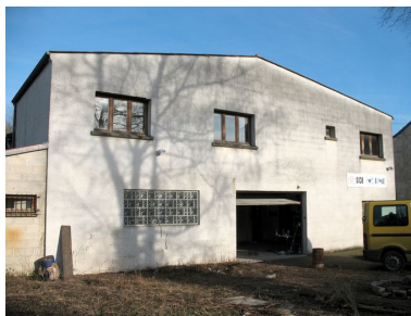
Le bâtiment principal construit pour la blanchisserie en 1959. Phot. Clarisse Lorieux IVR22_20096005027NUCA
