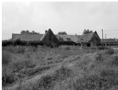
Vue générale. Phot. Philippe Dapvril IVR31_20045900468X
