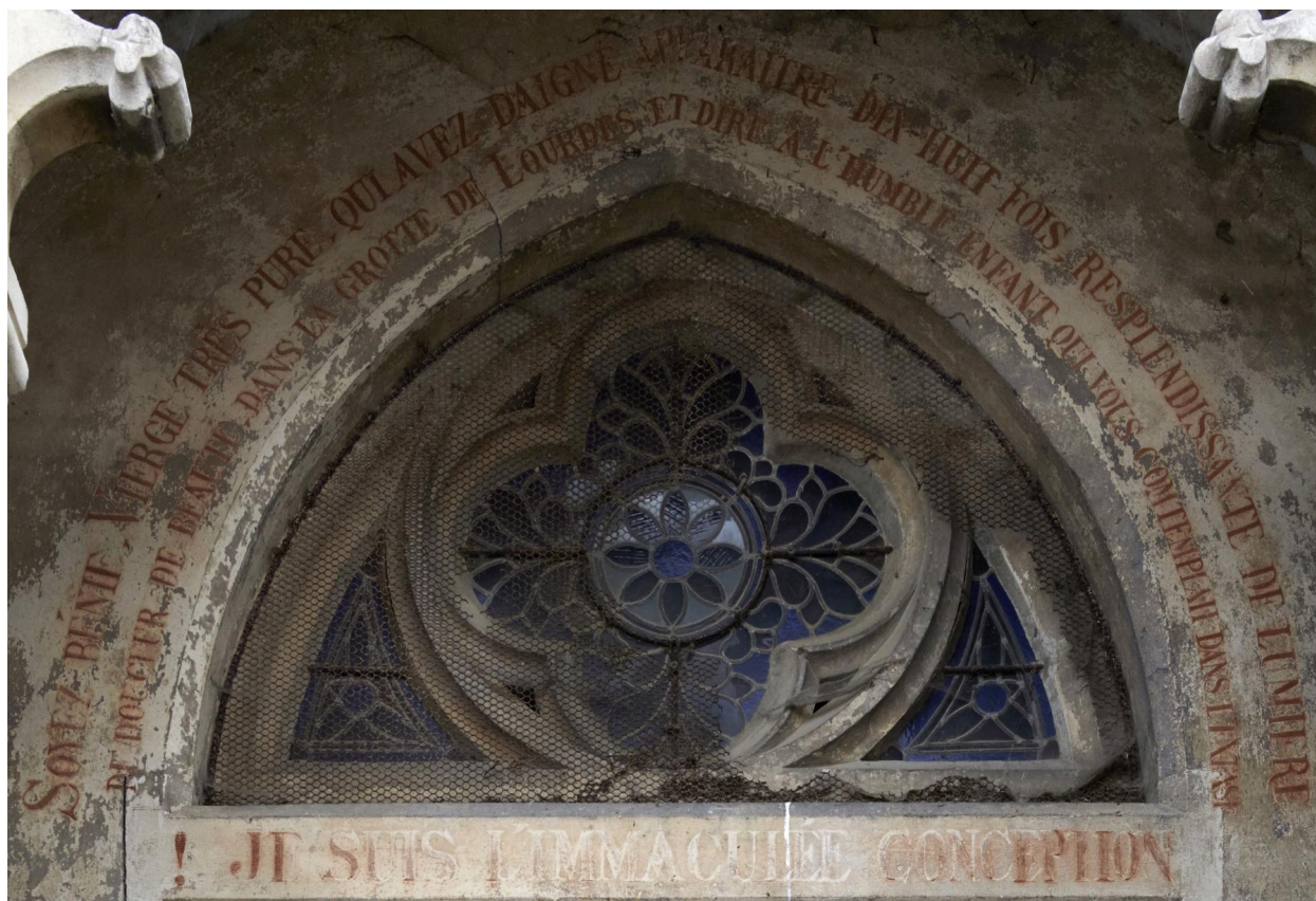
Éléments situés au-dessus de la porte d'entrée.
