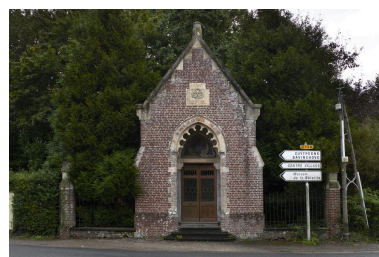
Façade principale de la chapelle donnant sur rue. Phot. Delphine Volto Jourdan IVR32_20245903031NUCA
