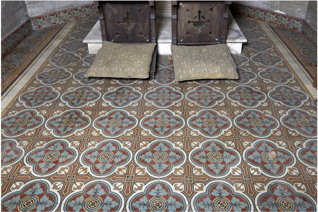
Détail du sol en carreaux ciment.
