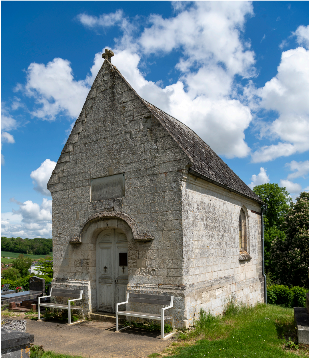
Chapelle du cimetière, vue prise depuis le sud-ouest.
