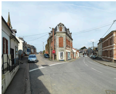
Vue d'ensemble. Phot. Thierry Lefébure IVR22_20138000106NUC2A
