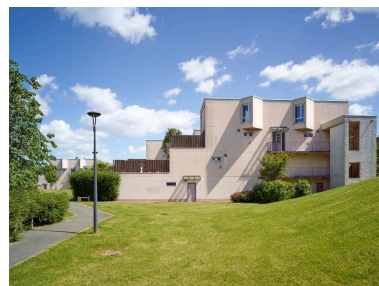
Un immeuble (n° 40) de profil : le logement de plain-pied est desservi par une entrée privative. Les baies en saillie sont une spécificité de cette opération. Phot. Pierre Thibaut IVR32_20185900683NUCA
