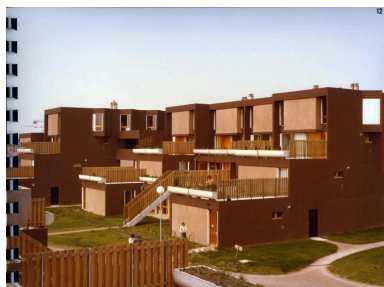
Vue vers le sud-ouest et l'immeuble n° 44 depuis la terrasse du n° 43 en 1978 ; on note les clôtures en bois et la palette de couleurs, chaudes et soutenues (AC Villeneuve d'Ascq ; 16W3). Phot. Pierre Thibaut IVR32_20215900442NUCA
