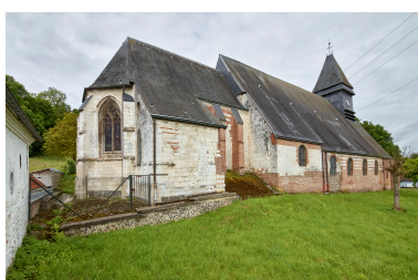
Vue de l'élévation est de l'église. Phot. Thierry Lefébure IVR32_20248000818NUCA
