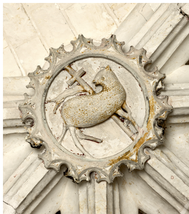
Intérieur, première clé de voûte du chœur. Phot. Thierry Lefébure IVR32_20248000886NUCA
