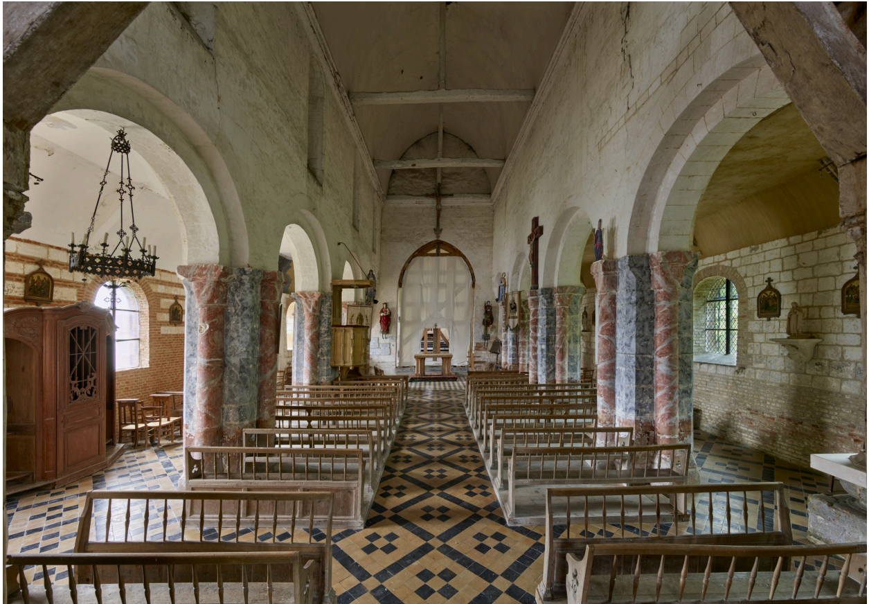
Intérieur, vue de la nef depuis l'entrée.
