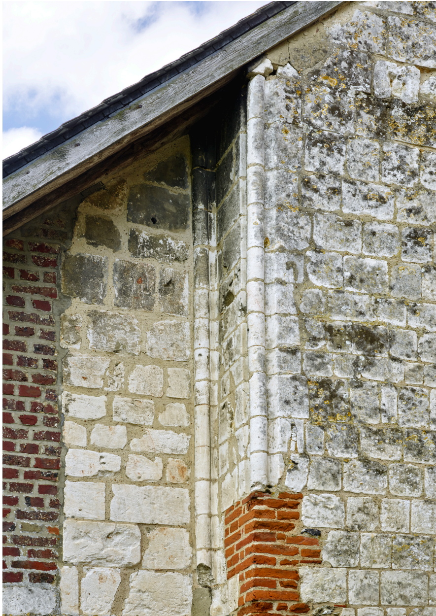
Détail des colonnettes engagées de l'élévation est du chevet.
