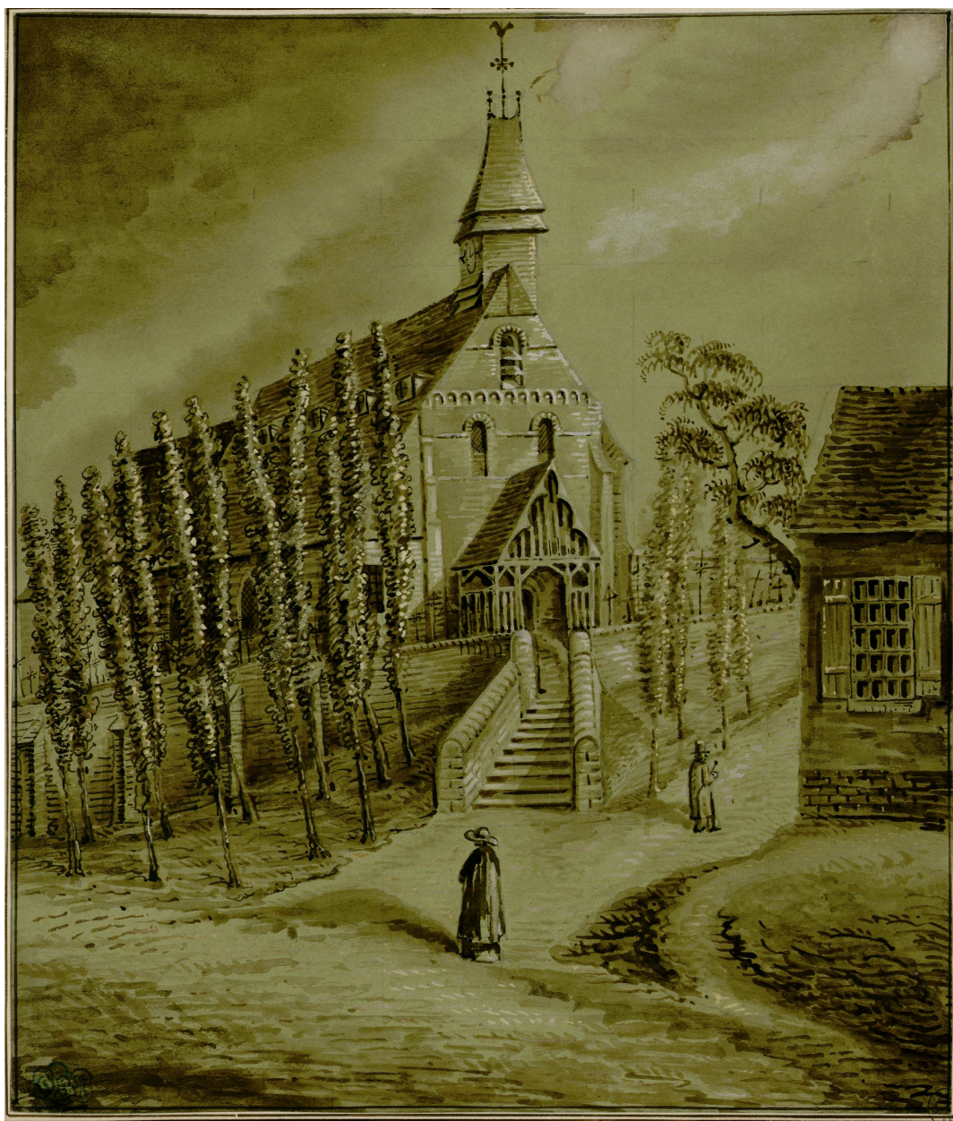
Église de Mareuil. Oswald Macqueron, d'après nature, janvier 1850 (Archives et Bibliothèque patrimoniale d'Abbeville ; Ab.M48).
