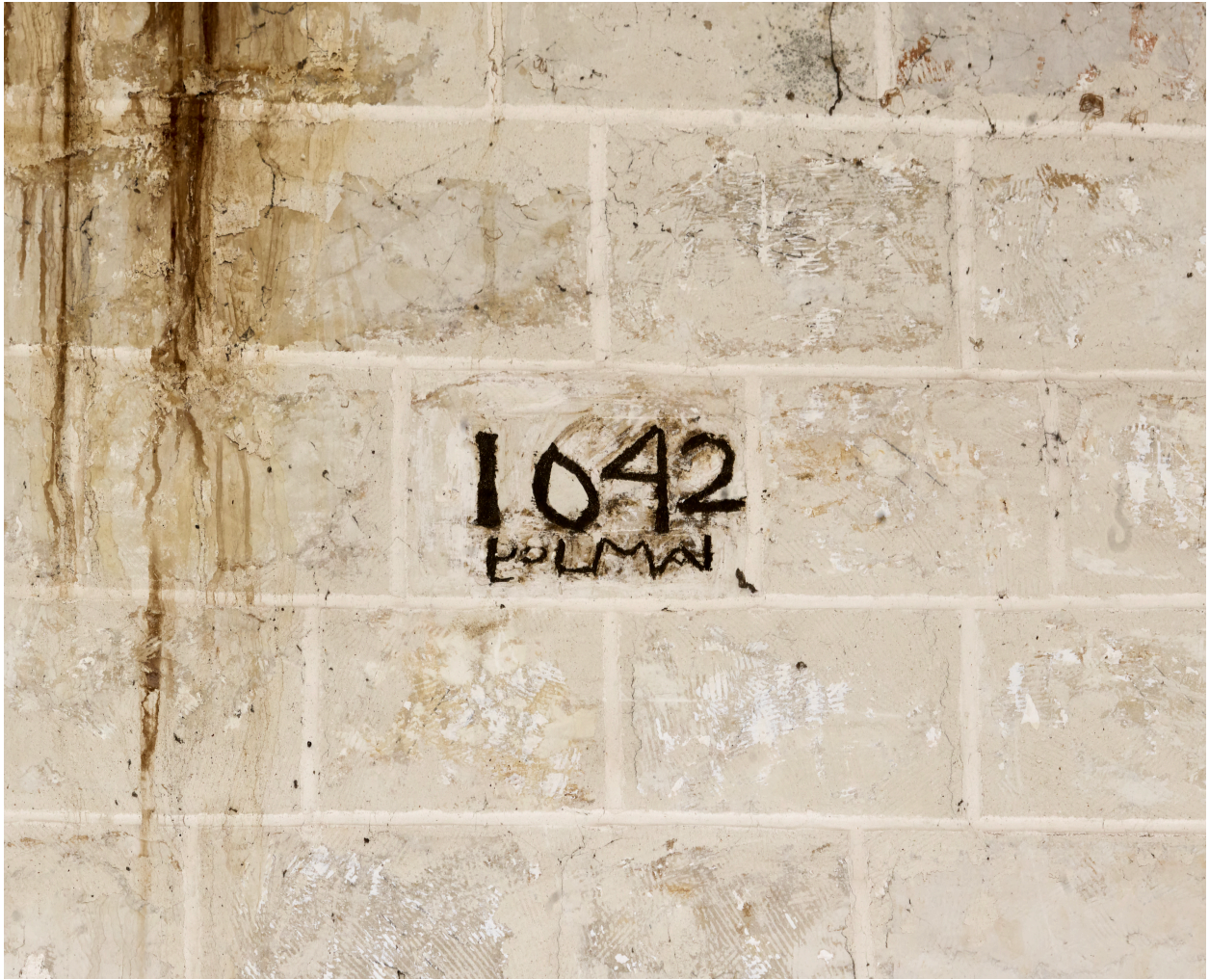
Intérieur, date portée dans l'ancienne croisée du transept.
