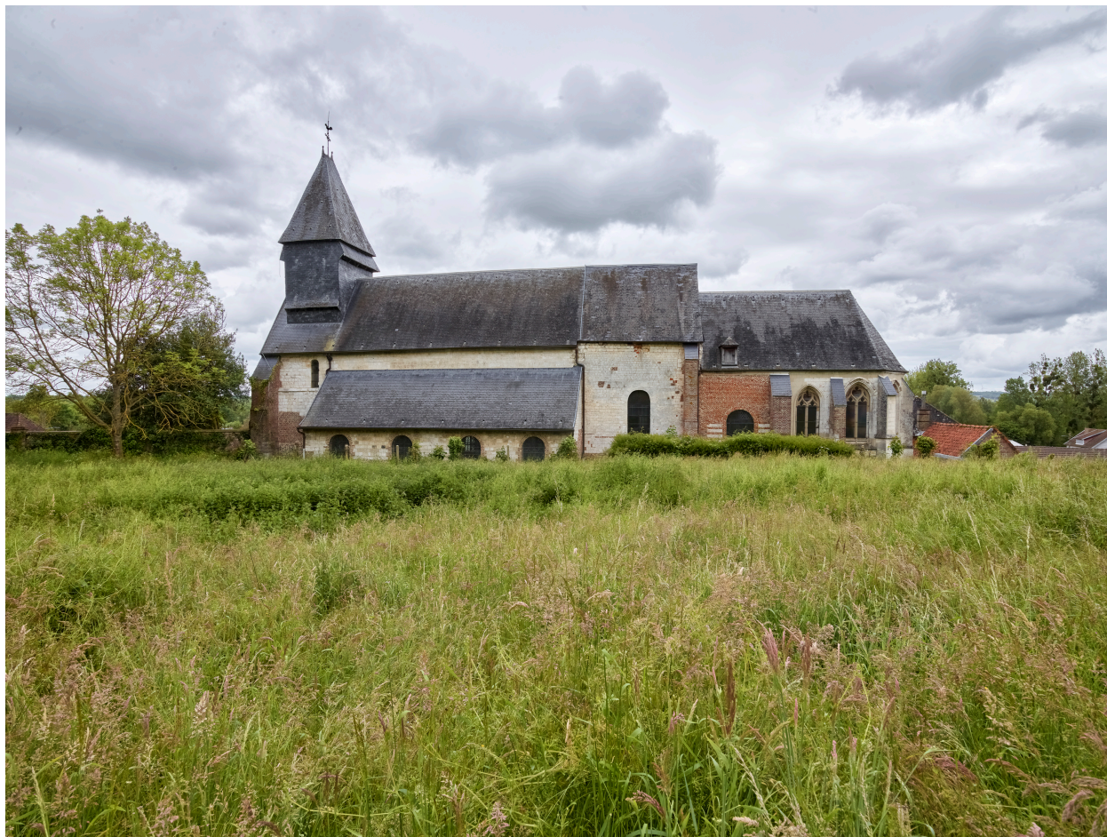
Vue d'ensemble de l'église, depuis l'ouest.
