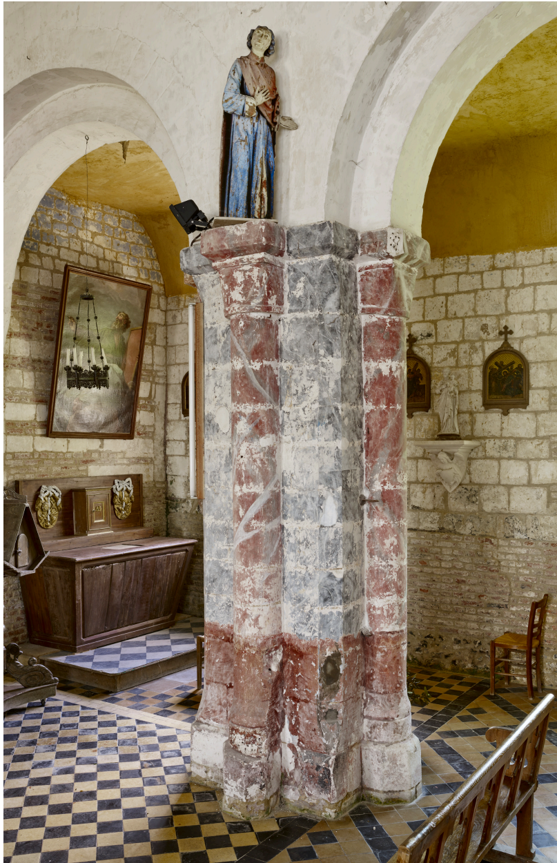
Intérieur, détail d'un pilier de la nef.
