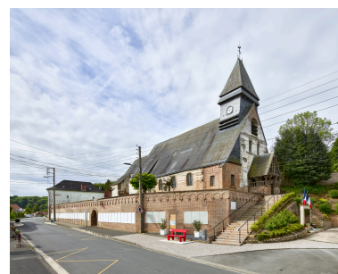
Vue d'ensemble de l'église, depuis le nord. Phot. Thierry Lefébure IVR32_20248001067NUCA
