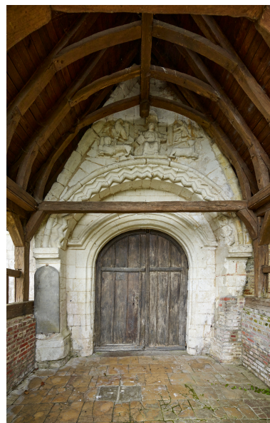
Portail nord. Phot. Thierry Lefébure IVR32_20248000829NUCA
