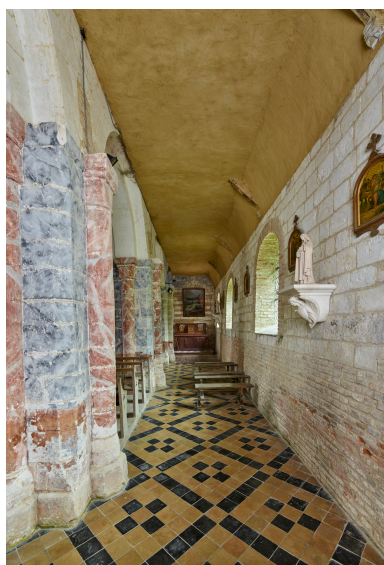
Intérieur, collatéral est, depuis le nord. Phot. Thierry Lefébure IVR32_20248000859NUCA
