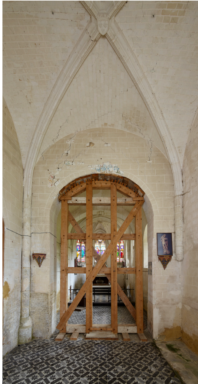
Intérieur, vue de l'ancienne croisée du transept, depuis la nef.
