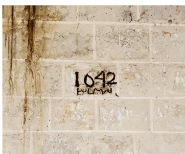
Intérieur, date portée dans l'ancienne croisée du transept. Phot. Thierry Lefébure IVR32_20248000869NUCA
