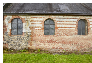
Détail de l'élévation extérieure du collatéral est. Phot. Thierry Lefébure IVR32_20248000822NUCA
