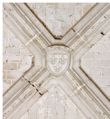
Intérieur, clé de voûte de l'ancienne croisée du transept. Phot. Thierry Lefébure IVR32_20248000868NUCA
