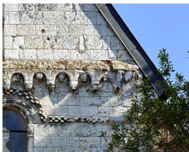
Détail de la frise de modillons sculptés, tiers droit. Phot. Thierry Lefébure IVR32_20248000837NUCA
