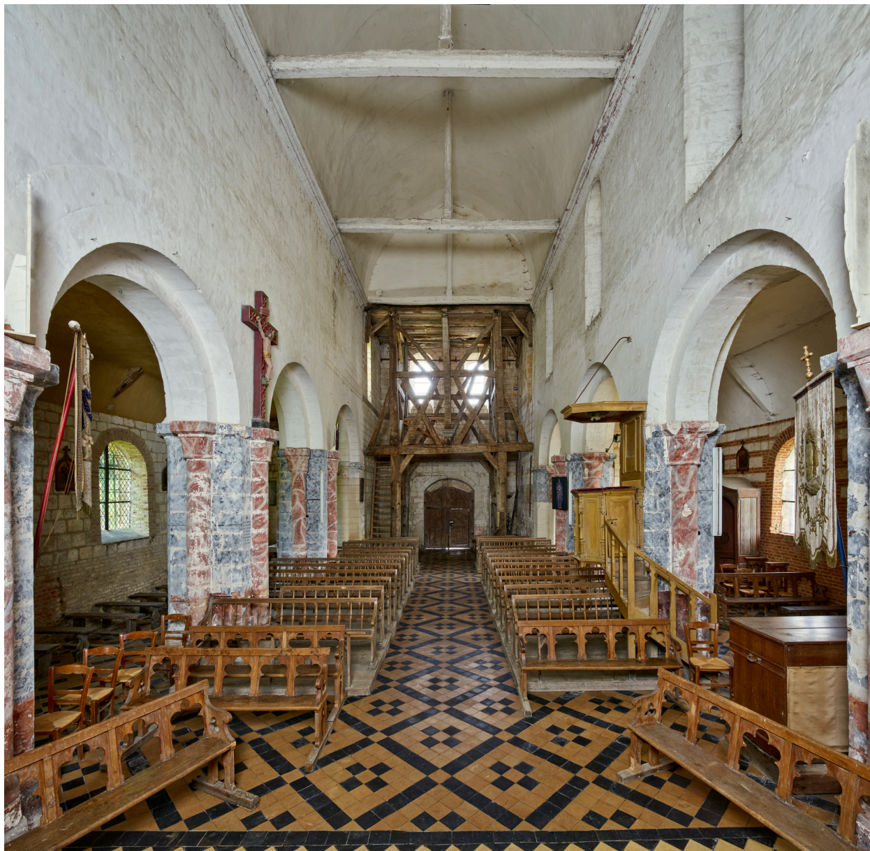
Intérieur, vue de la nef depuis l'ancienne croisée du transept.
