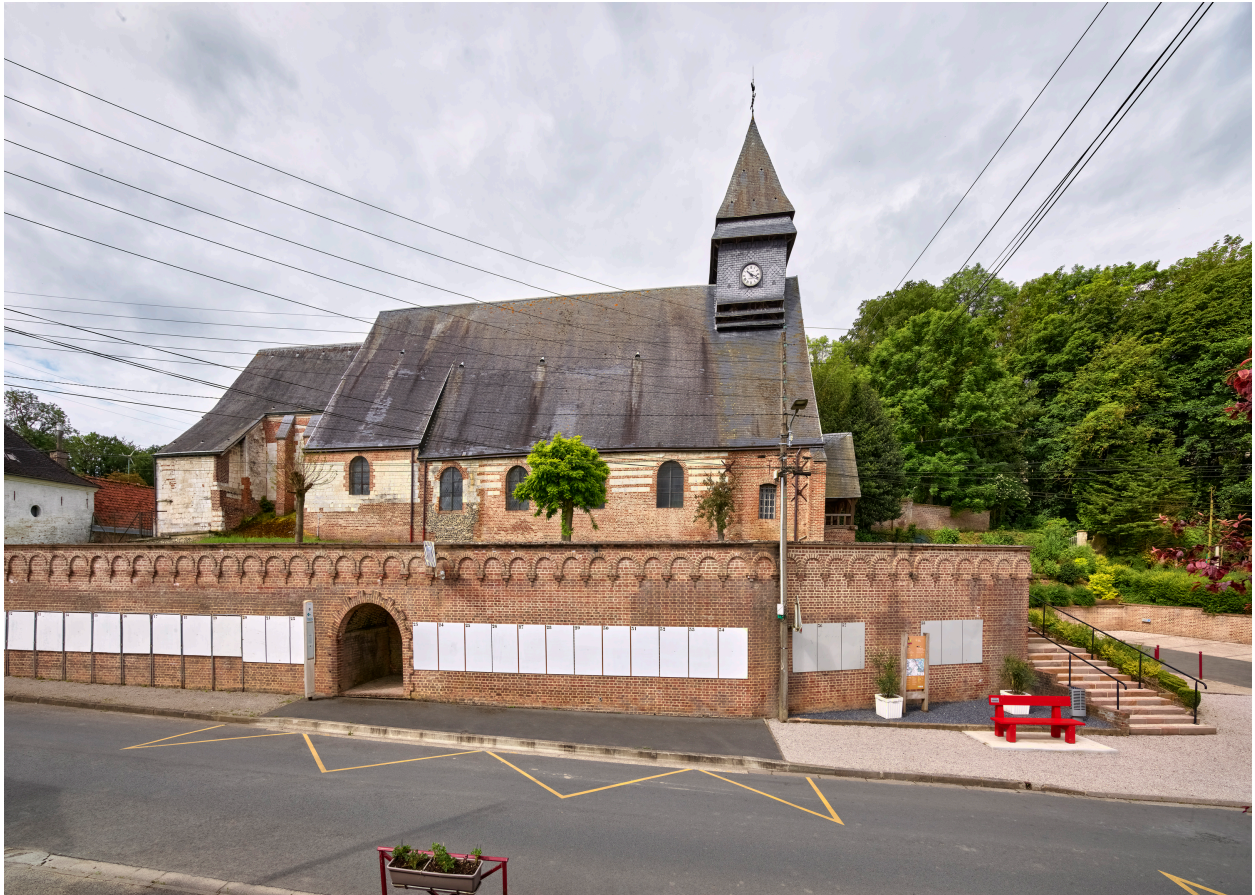
Vue d'ensemble de l'église, depuis l'est.
