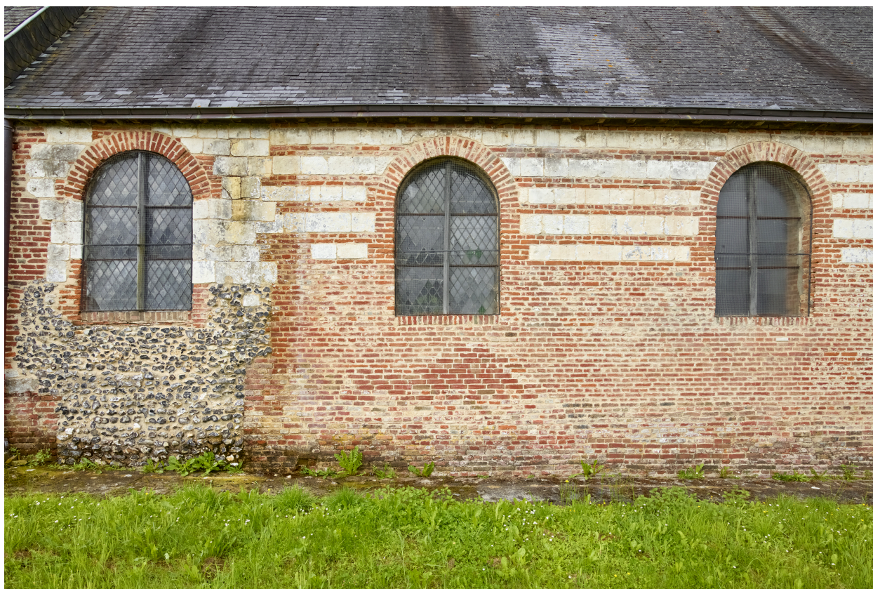
Détail de l'élévation extérieure du collatéral est.
