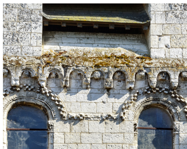
Détail de la frise de modillons sculptés, tiers central. Phot. Thierry Lefébure IVR32_20248000836NUCA
