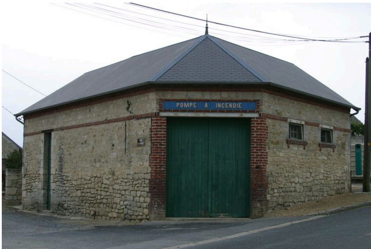
Vue de la pompe à incendie.
