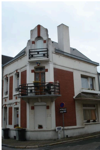
Vue générale. Phot. Julie Faure IVR31_20066200180NUCA
