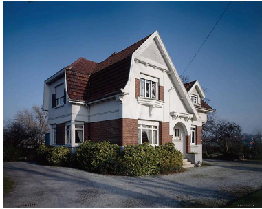
Élévation de trois quarts. Phot. Olivier Marlard IVR31_19955900530VA
