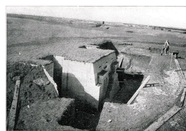
L'édifice une fois achevée au sein de la tranchée. On remarque le toit couvert d'herbe rendant l'abri invisible depuis le ciel. In: Deutsche Frontbauarbeit im Kriege, p.138 Phot. Staatsbibliothek zu Berlin (reproduction) IVR32_20176200537NUCA
