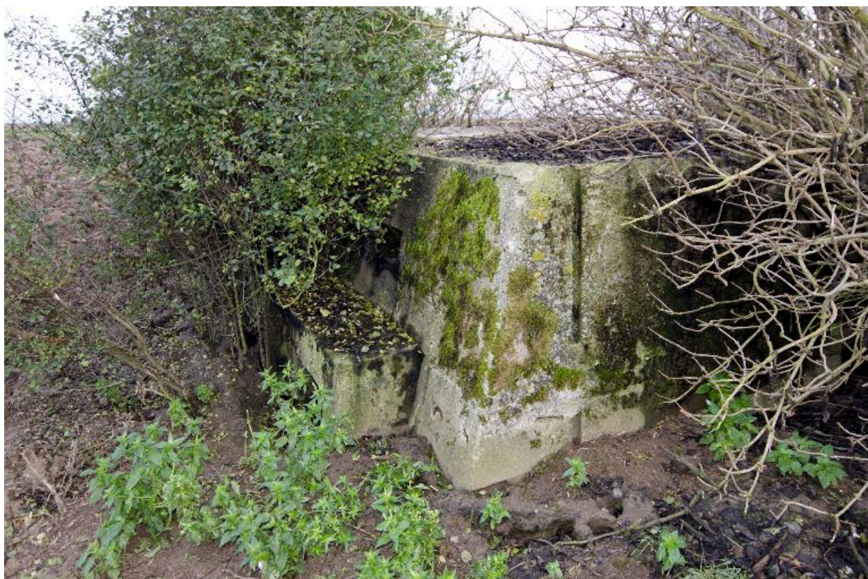
L'entrée nord, sa banquette de tir et sa niche à munitions, vers le sud
