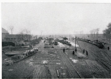
Parc à matériaux de Fontaine- lez-Croisilles (62). Fers à béton. in: Deutsche Frontbauarbeit im Kriege, p.128 Phot. Staatsbibliothek zu Berlin (reproduction) IVR32_20176200525NUCA
