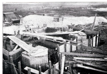
Le ferrailage et le coffrage des murs sont achevés. In: Deutsche Frontbauarbeit im Kriege, p.135
